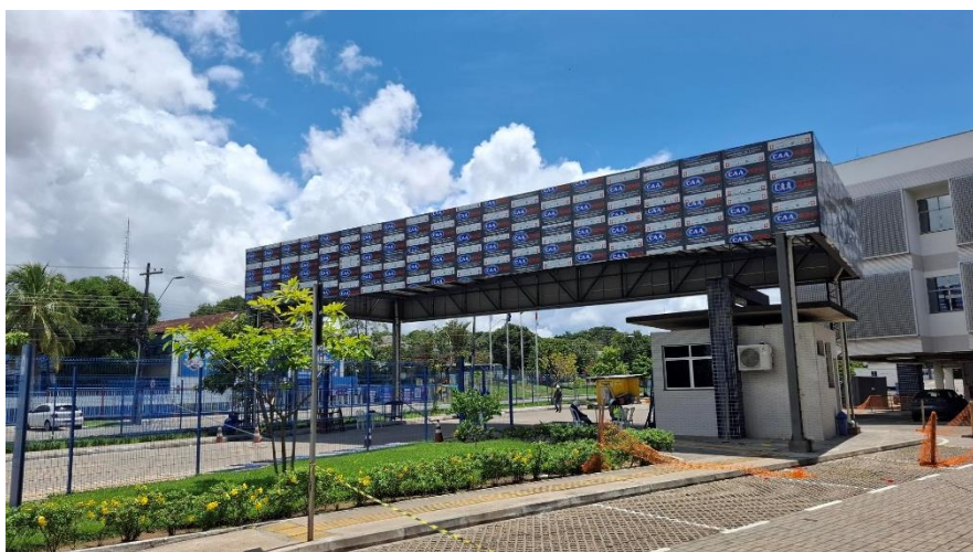
Foto 03 – Fachada principal. Fonte: Autor.
