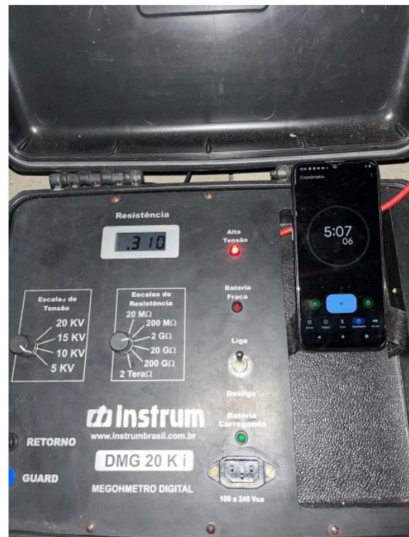
Ensaio cabo fase C
