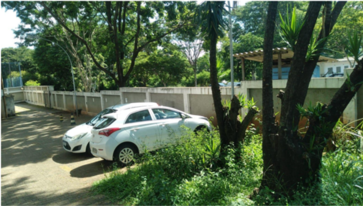
Figura 1: muro lateral DRF/Campinas
