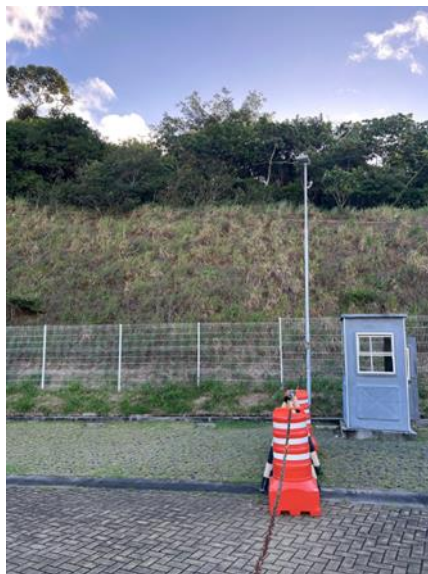
Fig. 9 Região em frente ao talude gramado – Vista frontal
