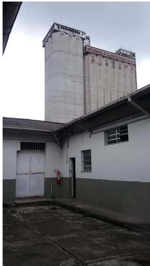
Edificação existente- vista interna
