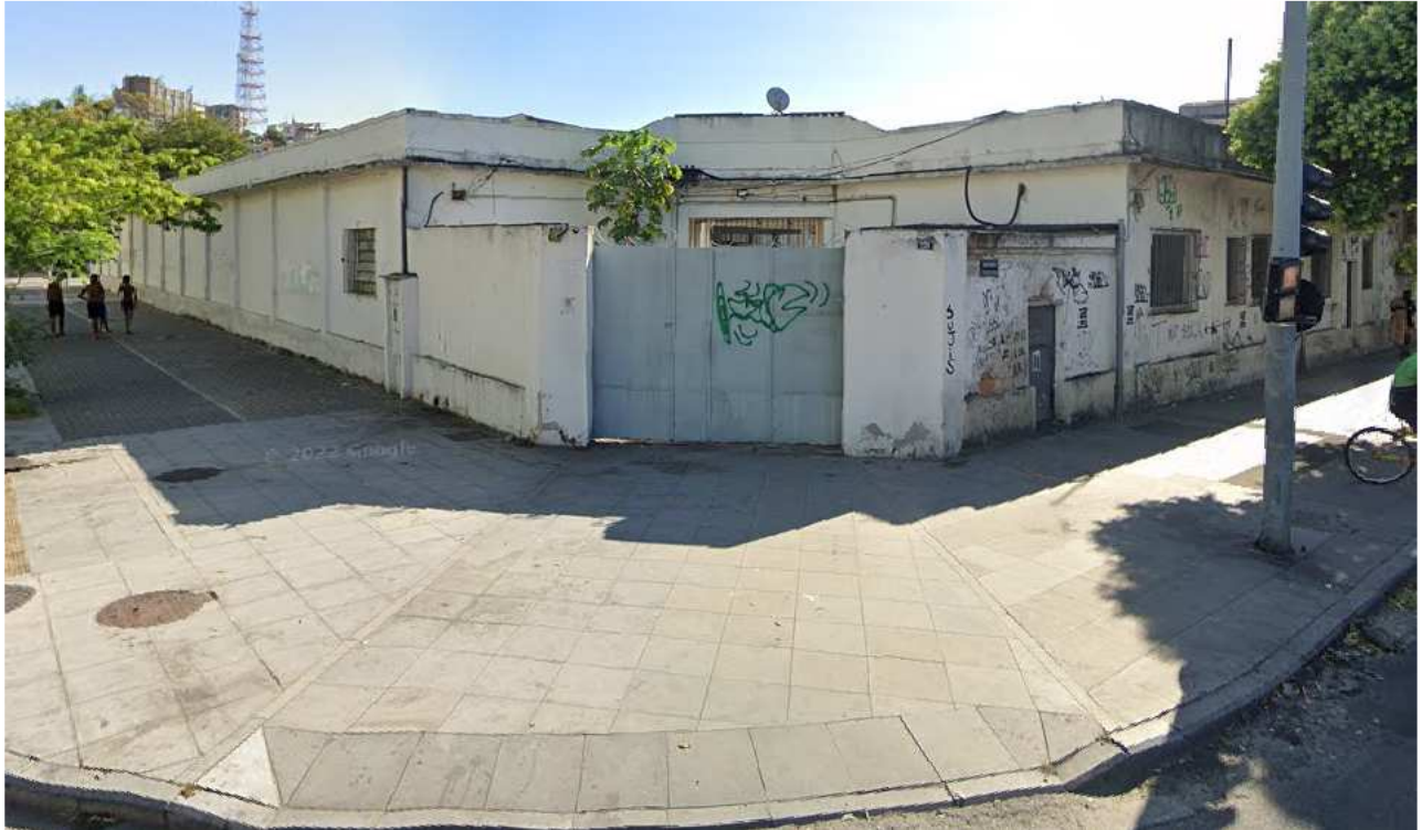
Edificação existente - esquina da Av. Venezuela com Rua Souza e Silva
