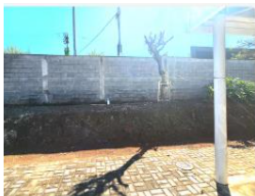
Figura 5: muro visto de dentro do imóvel
