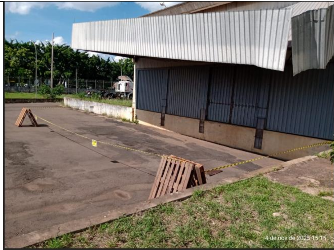
Imagem do local com isolamento
