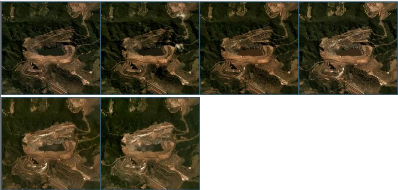
Figura 3: Movimentação de taludes em barragem da mina de Gongo Soco na cidade de Barão de Cocais-MG.
