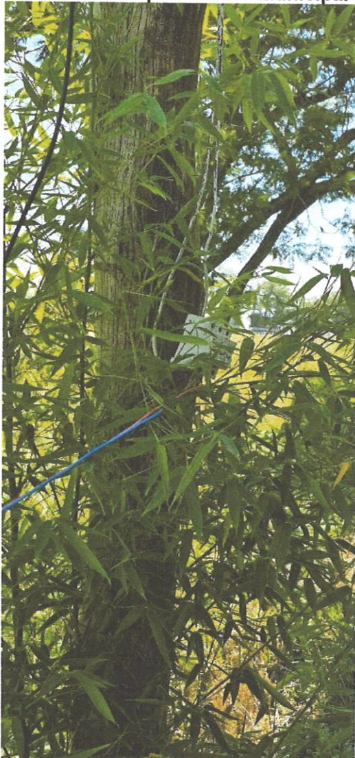
Disjuntor din /solto/exposto
