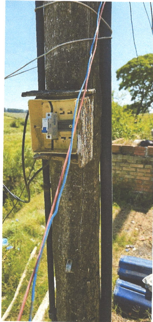
Caixa/disjuntor / condutores/exposto
