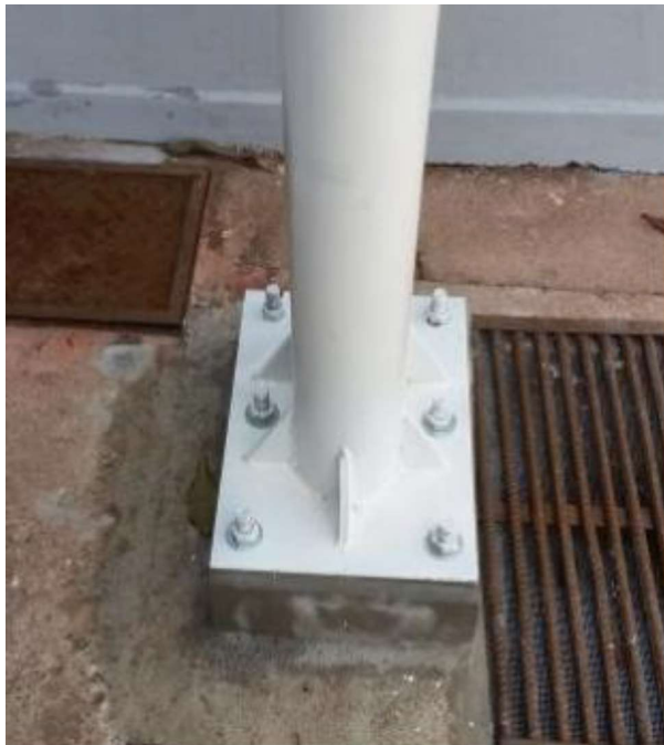
Figura 1 – Detalhe do bloco de fundação a ser executado, onde serão chumbados os pilares dos módulos de sombrite.
