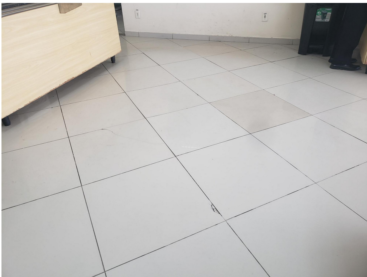
Figura 07: Salão de oficiais (troca de revestimento de alguns piso quebrados e trincados).
