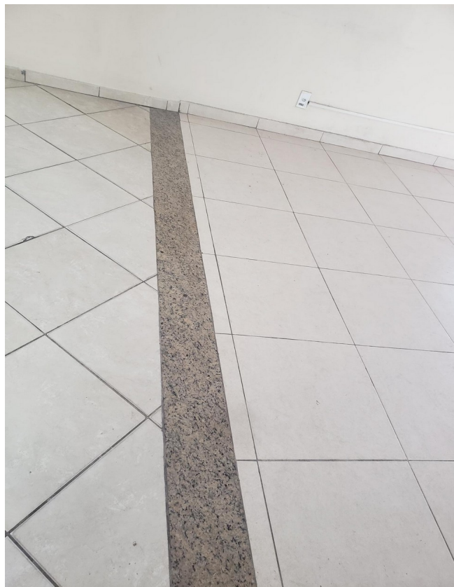
Figura 08: Salão de oficiais (Troca de soleira do salão de cabos e marinheiros).
