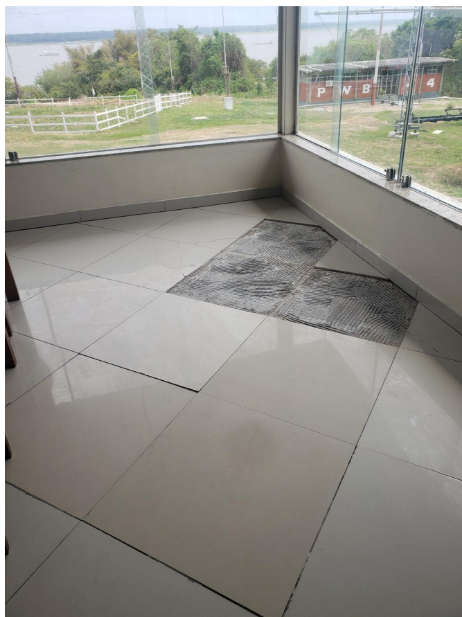
Figura 09: Salão de oficiais, instalação de porcelanato em alguns pontos (troca de porcelanato quebrado).
