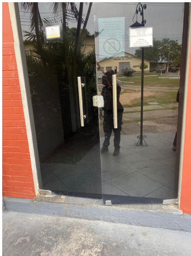
Figura 10: Retirada e reinstalação de porta de vidro para troca de soleira.
