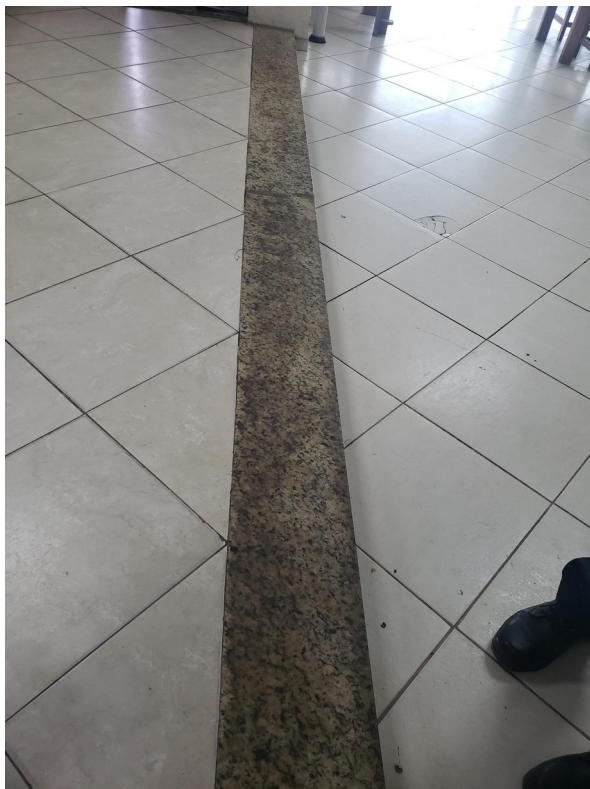
Figura 04: Salão de cabos suboficiais e sargentos (troca de revestimento de todo o piso e parede, soleira, pintura).
