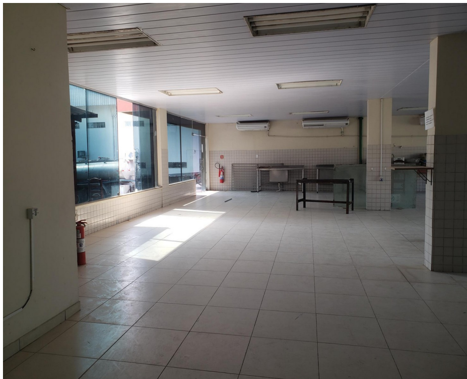
Figura 01: Salão de cabos e marinheiros (troca de revestimento de todo o piso e parede, pintura).
