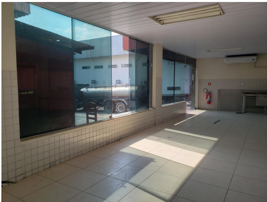
Figura 02: Salão de cabos e marinheiros (troca de revestimento de todo o piso e parede, soleira, pintura).
