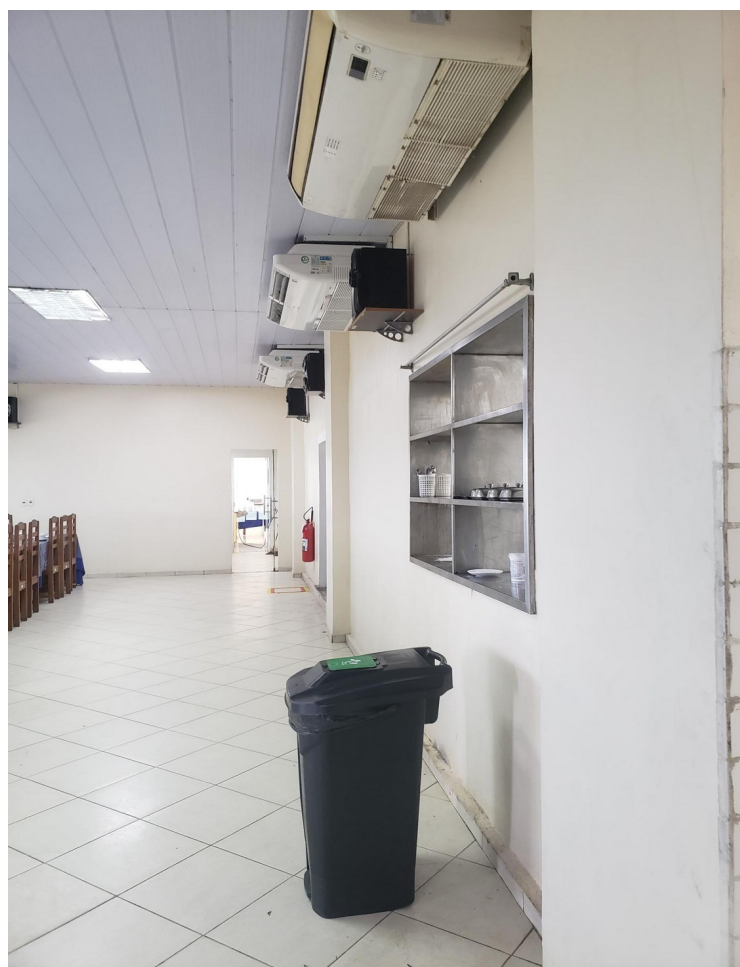
Figura 03: Salão de cabos suboficiais e sargentos (troca de revestimento de todo o piso e parede, pintura).
