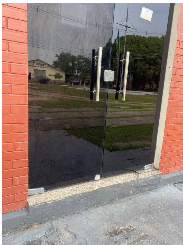
Figura 11: Retirada e reinstalação de porta de vidro para troca de soleira.
