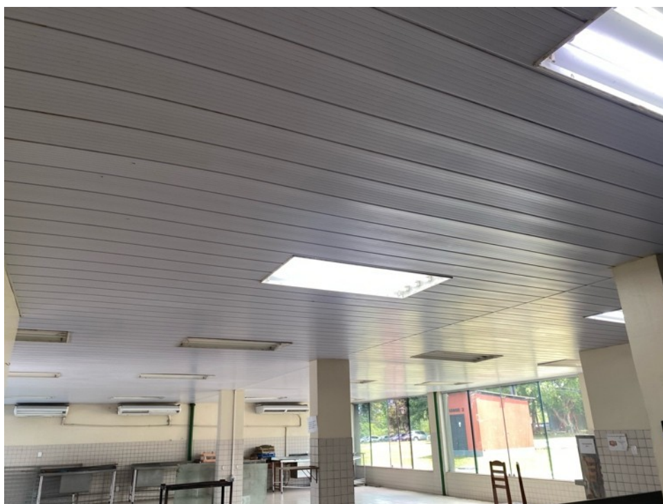
Figura 02: Forro do salão de cabos e marinheiros
