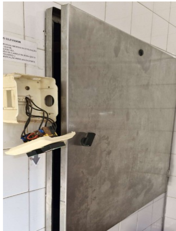
Elevador de carga desativado por obsolescência e avarias irreparáveis
