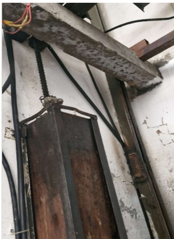
Elevador de carga desativado por obsolescência e avarias irreparáveis
