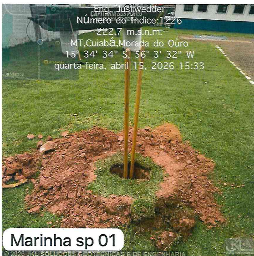
Imagem 3 – Marinha do Brasil - Capit. Fluvial de Cuiabá/MT - Furo SP 01 - Amostra de Prof. Inicial, entre 00,00m à 1,00m - 1 Amostra.
