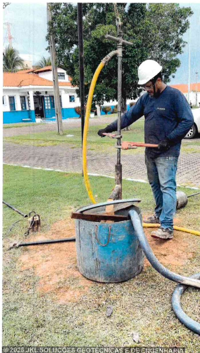
Imagem 10 – Marinha do Brasil - Capit. Fluvial de Cuiabá MT - Furo SP 01 - Lavagem do Furo
