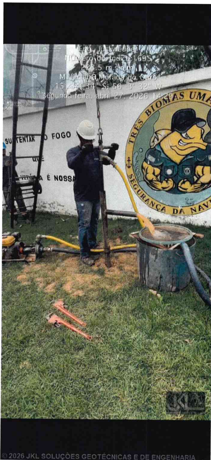
Imagem 21 – Marinha do Brasil - Capit. Fluvial de Cuiabá MT - Furo SP 02 - Lavagem do Furo
