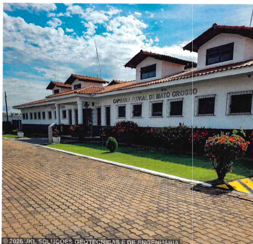
Imagem 2 – Geral da Edificação
