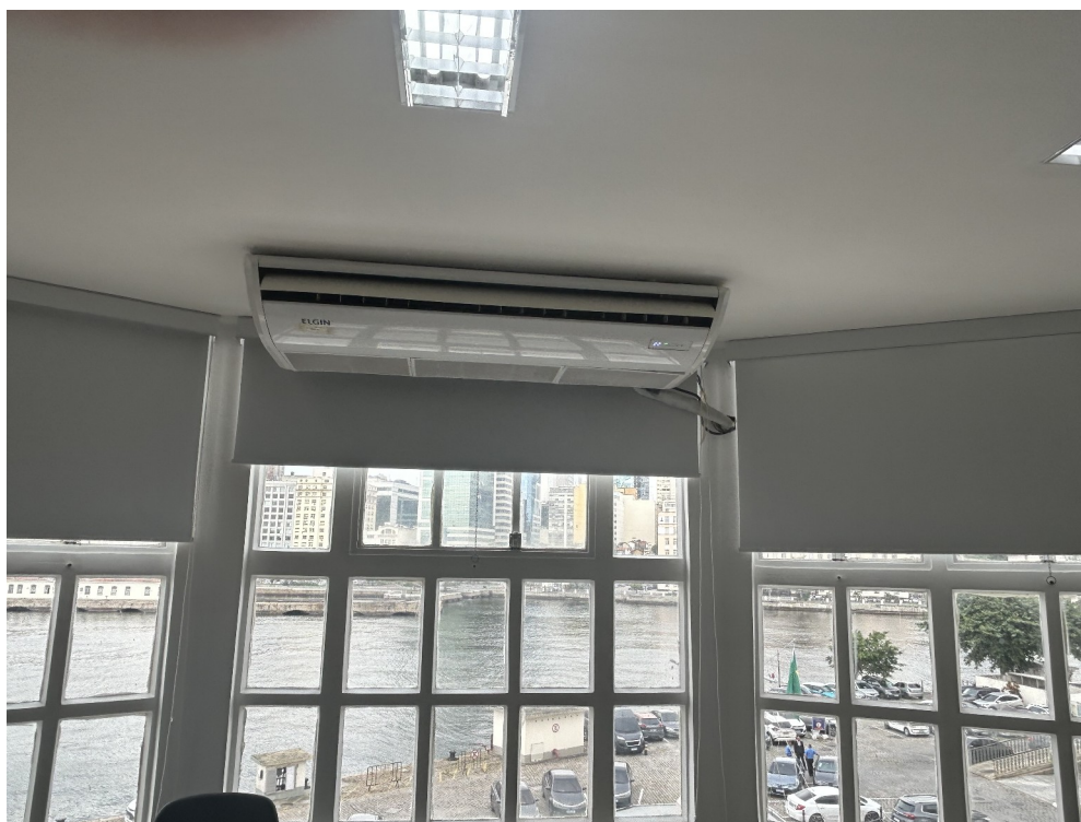
Figura 1: Local atual da instalação da unidade evaporadora. Foto meramente ilustrativa. A imagem visa demonstrar a complexidade do ambiente e o padrão de fixação exigido. O modelo do equipamento existente será substituído por novo aparelho que atenda às especificações mínimas
