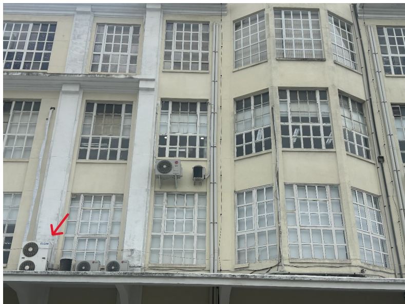
Figura 2: Local atual da instalação da condensadora (Marquise). Foto meramente ilustrativa.
