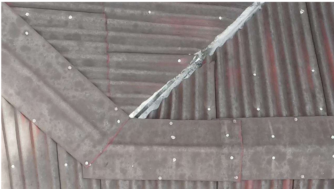
Foto 08 - Detalhe de interseção entre cumeeira e espigões
