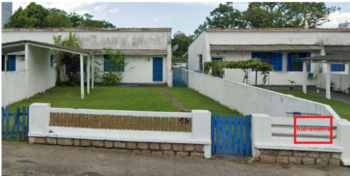
FIGURA 04 – LOCAL PARA INSTALAÇÃO DO ABRIGO DE HIDRÔMETRO
