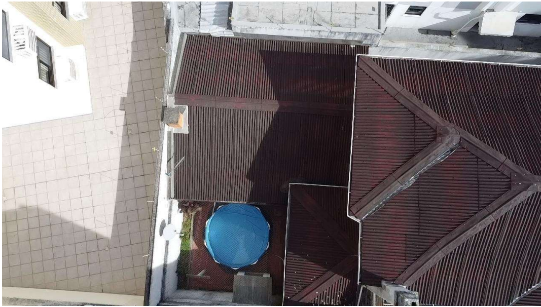
Foto 01 - Vista aérea parcial da cobertura
