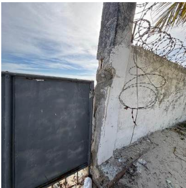
Figura 61: Pilar de sustentação do portão não suporta, chumbamento ineficiente
