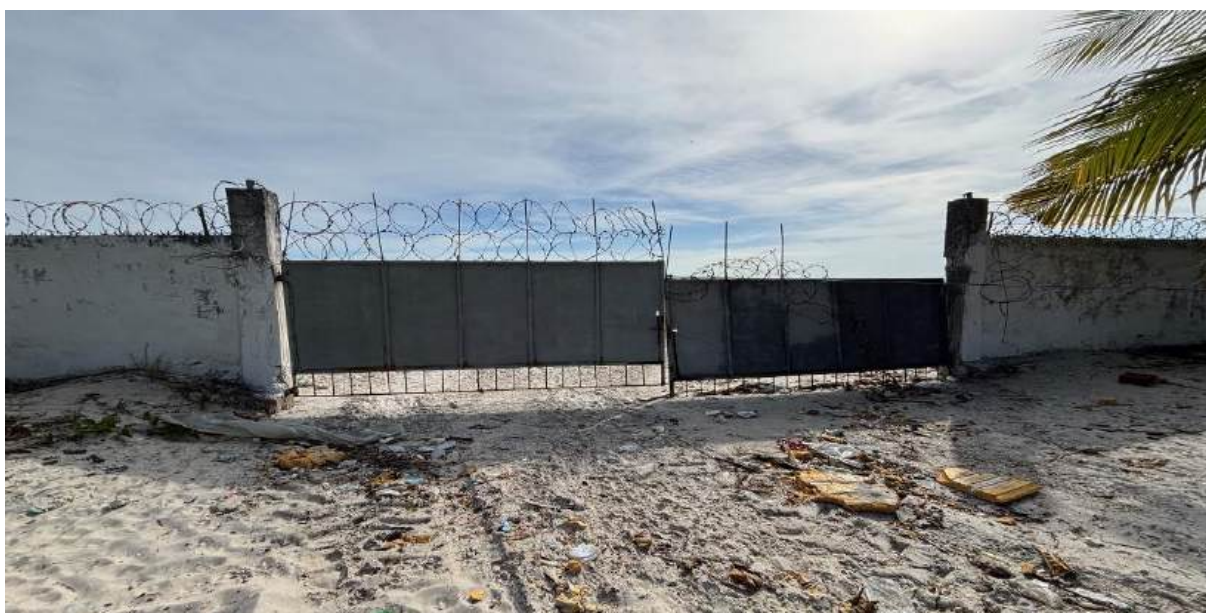
Figura 60: Portão acesso ao mar, Pilares de sustentação do portão com chumbamento ineficiente
