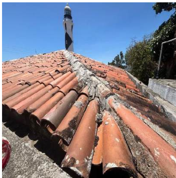
Figura 48: Desgaste superficial acentuado das telhas cerâmicas.
