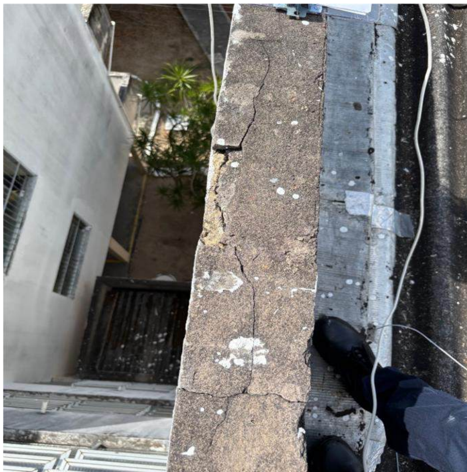
Figura 6: Fissuras e rachaduras em parte superior de platibanda
