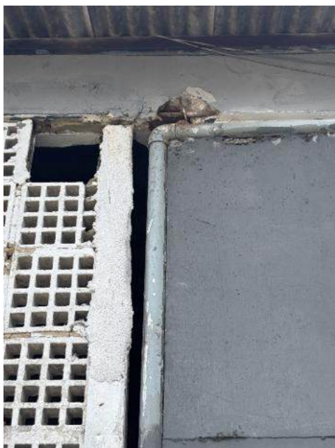
Figura 59: Detalhe Amarração Viga-Portão
