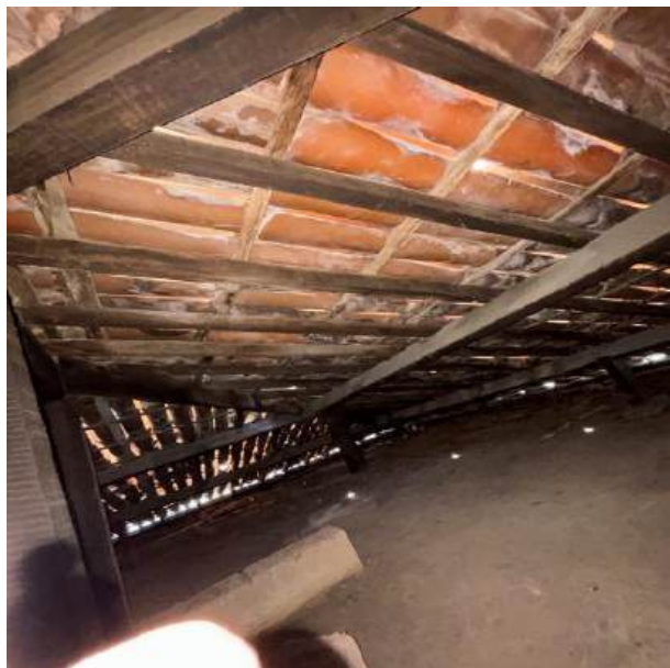
Figura 49: Incidência de luz no interior do entre-forro, indicando falhas de vedação.
