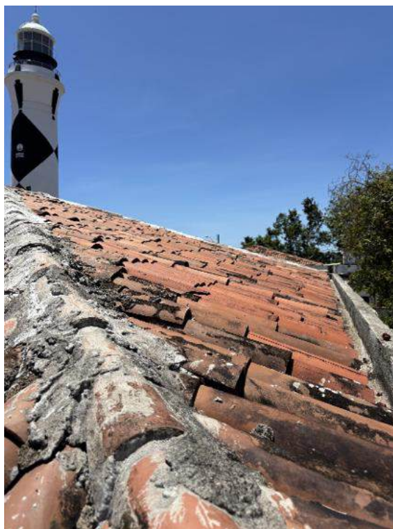
Figura 50: Fissuras e lascamentos nas peças cerâmicas.
