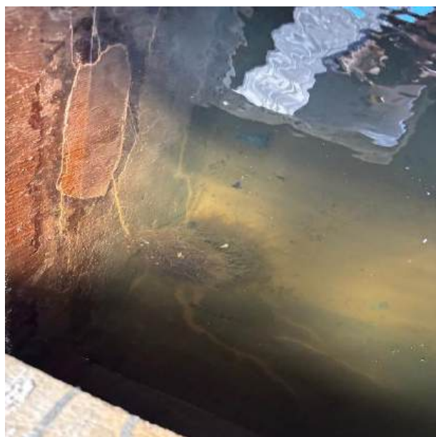
Figura 43: Cisterna com vegetação entrando por rachaduras
