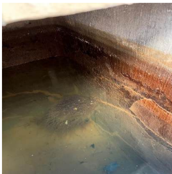
Figura 44: Cisterna com diversas fissuras/rachaduras
