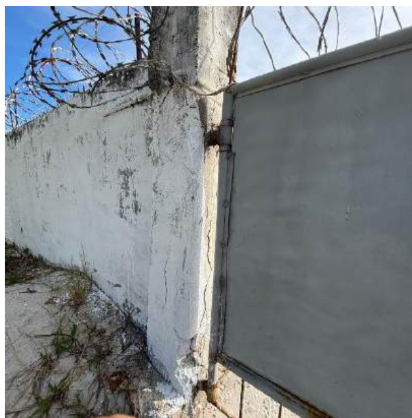
Figura 62: Pilar de sustentação com chumbamento ineficiente
