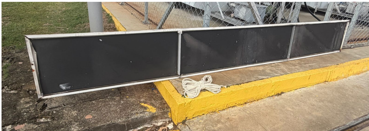
Figura 1 – Registro fotográfico da placa e da estrutura metálica existente.
