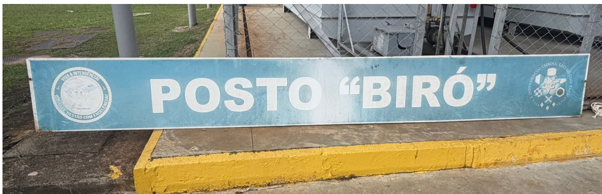
Figura 2 – Registro fotográfico da placa e da estrutura metálica existente.
