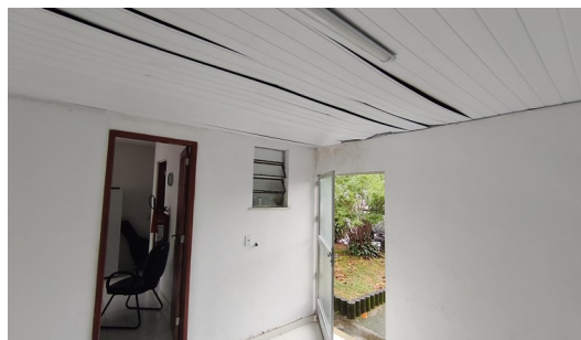
5.7.4. Goteiras geradas em virtude do desgaste do telhado.
