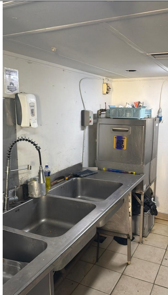
Foto 04 - Área de lavagem/higienização, com pias, equipamentos e infraestrutura aparente, demandando iluminação adequada à inspeção visual e limpeza.
