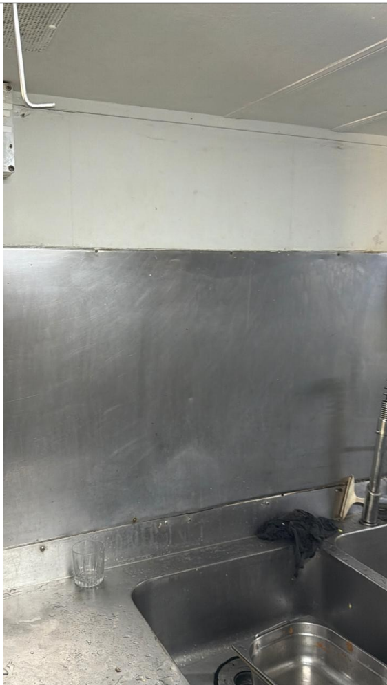
Foto 05 - Bancada e revestimento metálico da área de lavagem/preparo, com necessidade de claridade suficiente para higienização e identificação de resíduos.
