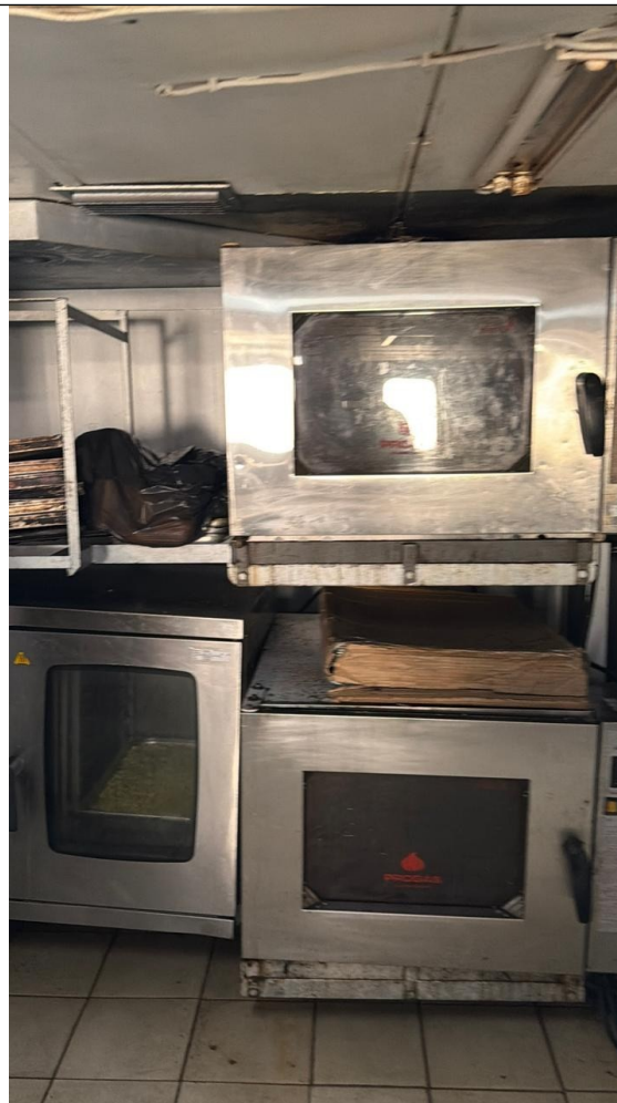
Foto 06 - Área de fornos e equipamentos térmicos, evidenciando ambiente de cocção que demanda iluminação segura e funcional.
