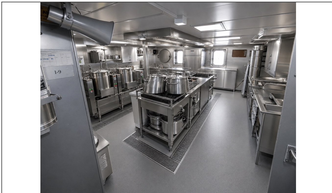
Foto 11 - Imagem de referência visual do padrão técnico pretendido: piso contínuo, claro, regular, integrado às grelhas e de fácil higienização.
