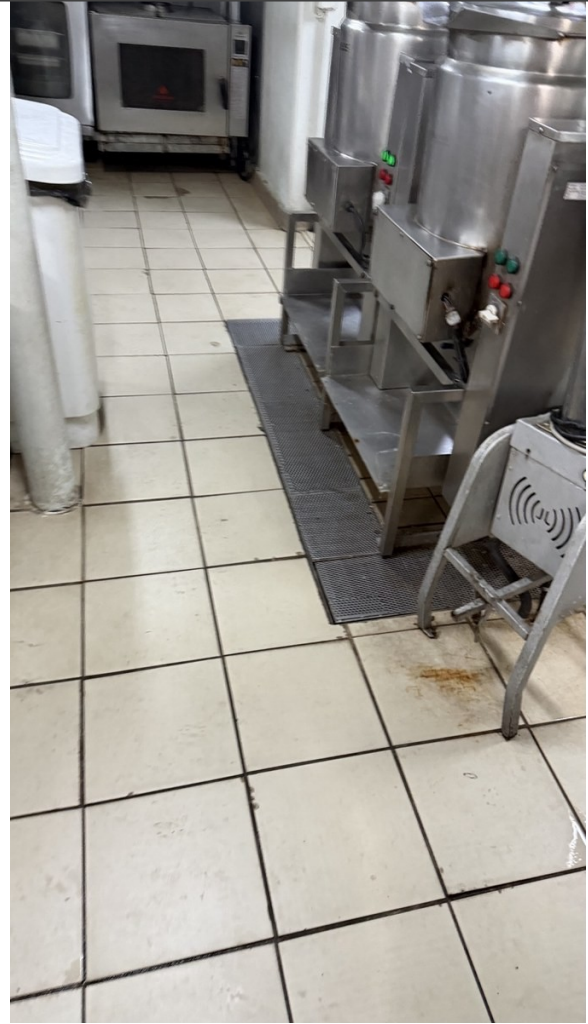
Foto 10 - Vista de área com equipamentos, grelhas e marcas de umidade, demonstrando a necessidade de melhorar segurança, limpeza e escoamento.
