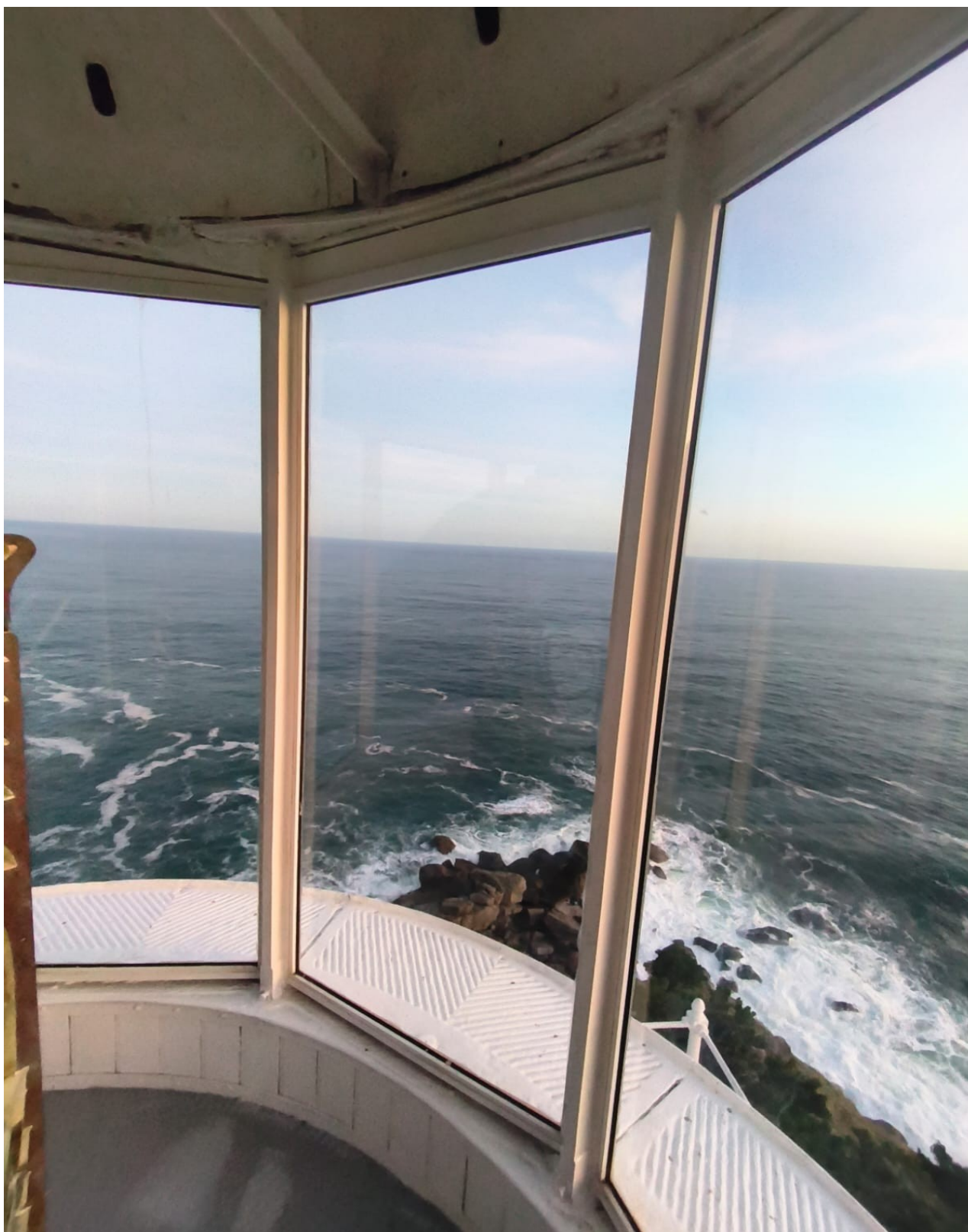
Figura 2: IMAGEM DA VIDRAÇARIA DA CÚPULA – SERVIÇO DE CONFECÇÃO, FORNECIMENTO E INSTALAÇÃO DE 10 SANEFAS TIPO ROLÔ COM TECIDO BLACKOUT NA COR BRANCA.
