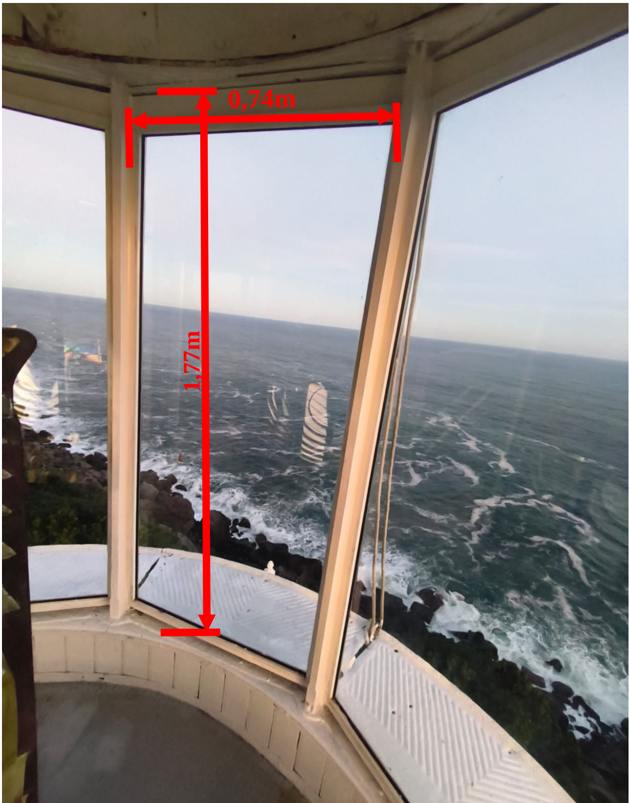
Figura 3: IMAGEM DA VIDRAÇARIA DA CÚPULA – DIMENSÕES DO VÃO: 0,74M DE LARGURA POR 1,77M DE ALTURA.
