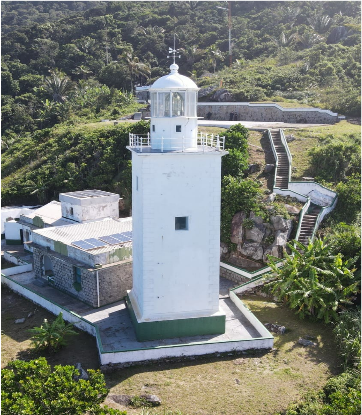
Figura 1: FOTO AÉREA DA TORRE DO FAROL, ONDE SERÃO REALIZADOS OS SERVIÇOS
