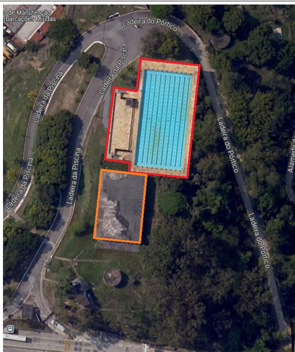
Figura 6: Área da Piscina e do Reservatório de Água
