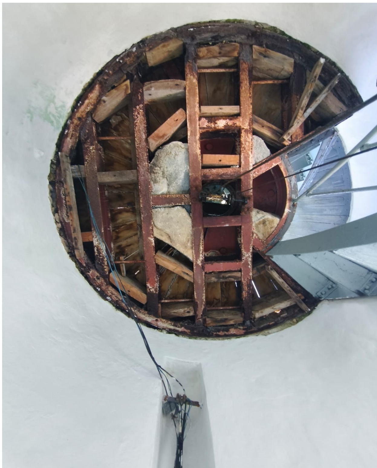
Figura 15: IMAGEM DO MEZANINO DIÂMETRO DE 2.54metros - SERVIÇO DE INSTALAÇÃO DE FORRO PVC COM MOLDURA DE ACABAMENTO
