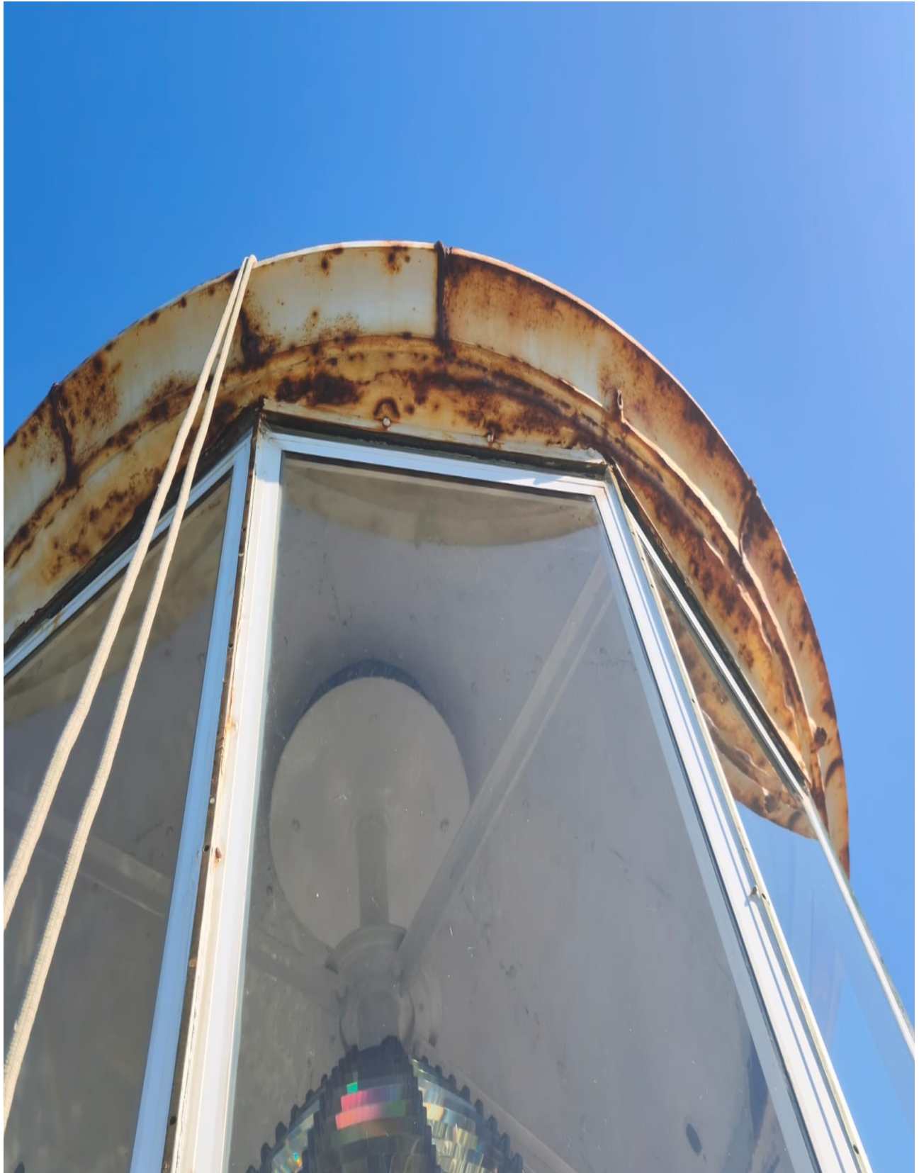
Figura 6: FOTO PARCIAL DO TETO EXTERNO DA CÚPULA E DAS COLUNAS DA VIDRAÇA - SERVIÇO DE REMOÇÃO DA TINTA ANTIGA, FERRUGEM E CONTAMINANTES, TRATAMENTO ANTICORROSIVO E APLICAÇÃO DE TINTA
