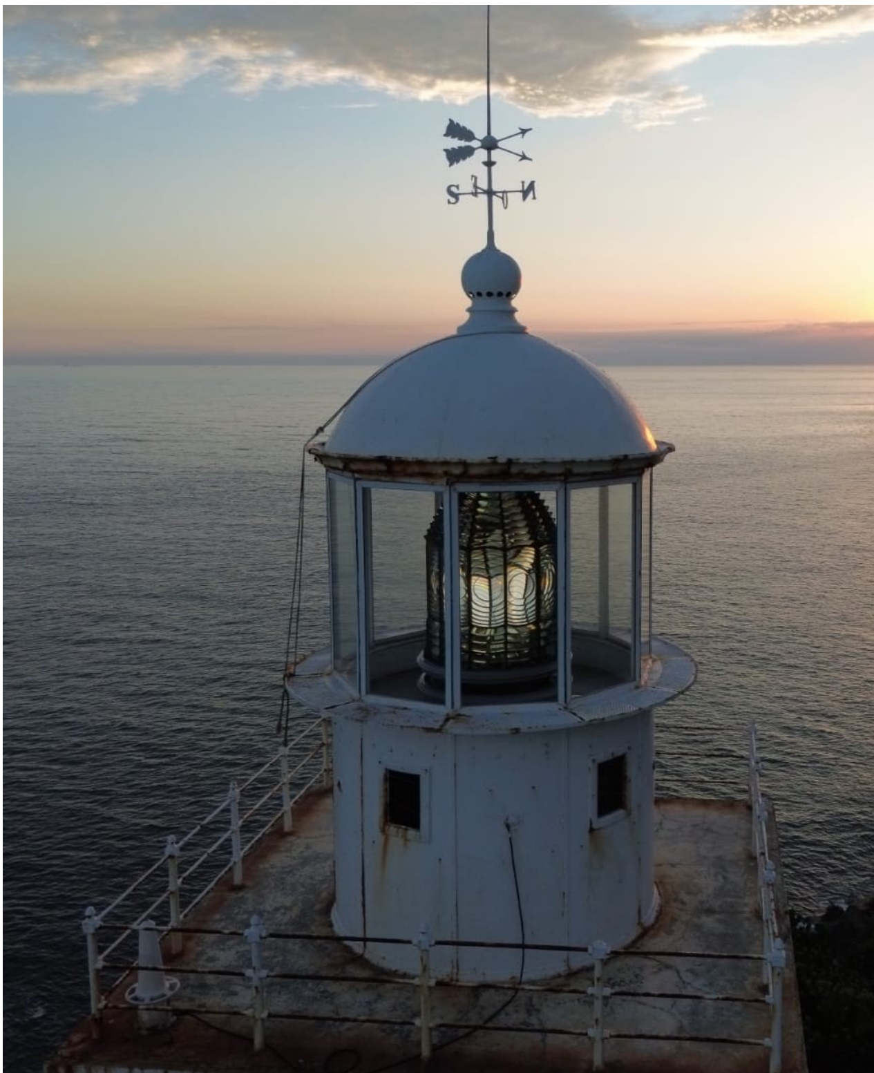
Figura 16: IMAGEM AÉREA DA CÚPULA PARA VISLUMBRE DOS SERVIÇOS A SEREM EXECUTADOS
