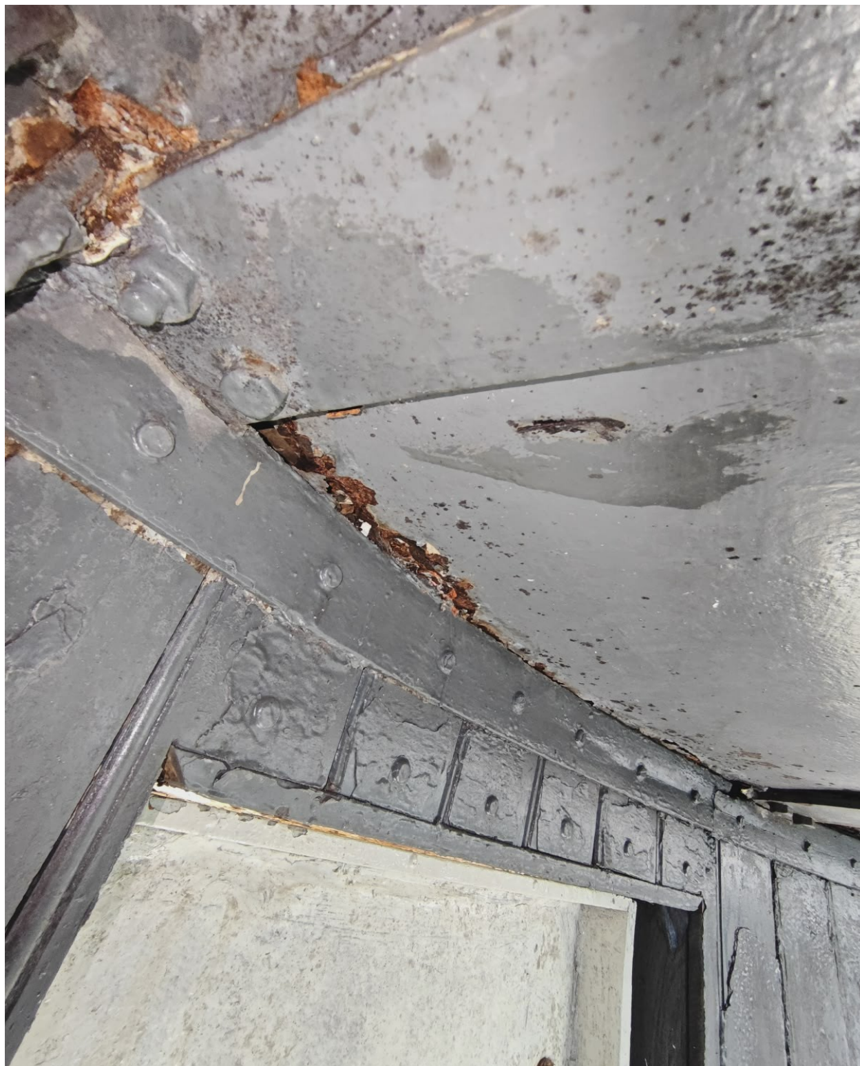
Figura 14: IMAGEM DA PARTE INFERIOR DO PISO DA CÚPULA - SERVIÇO DE REMOÇÃO DA TINTA ANTIGA, FERRUGEM E CONTAMINANTES, TRATAMENTO ANTICORROSIVO E APLICAÇÃO DE TINTA
