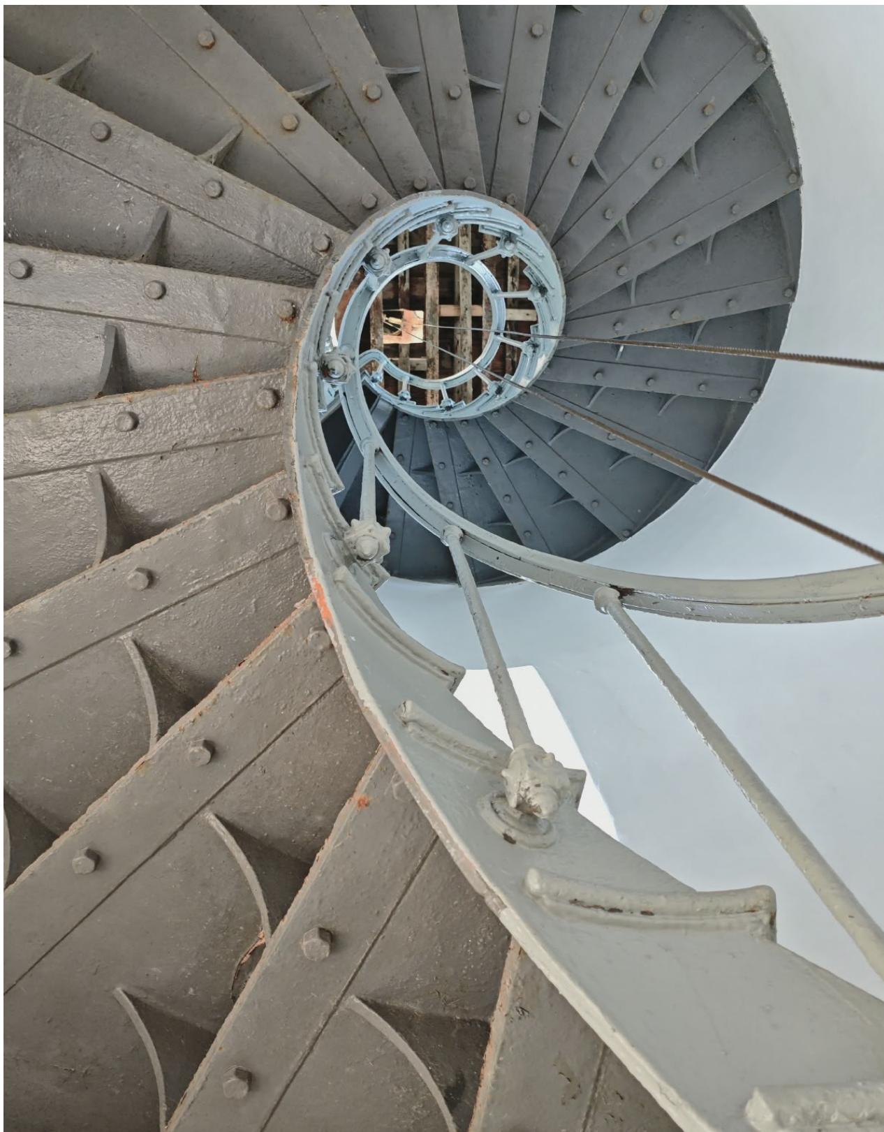
Figura 3: IMAGEM DA ESCADARIA VISTA DE BAIXO - SERVIÇO DE REMOÇÃO DA TINTA ANTIGA, FERRUGEM E CONTAMINANTES, TRATAMENTO ANTICORROSIVO E APLICAÇÃO DE TINTA
