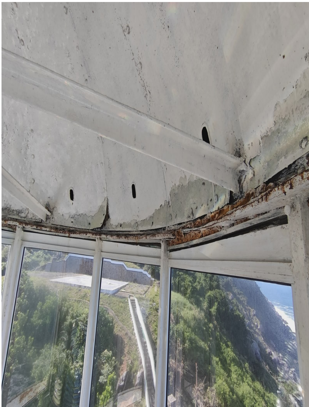
Figura 4: IMAGEM PARCIAL DO TETO DA CÚPULA – SERVIÇO DE RETIRADA DAS CHAPAS PARA REMOÇÃO DA TINTA ANTIGA, FERRUGEM E CONTAMINANTES, TRATAMENTO ANTICORROSIVO E APLICAÇÃO DE TINTA, DAS COLUNAS E DA PARTE INTERIOR DO TETO, RECOLOCAÇÃO DAS CHAPAS TRATADAS E PINTADAS.
