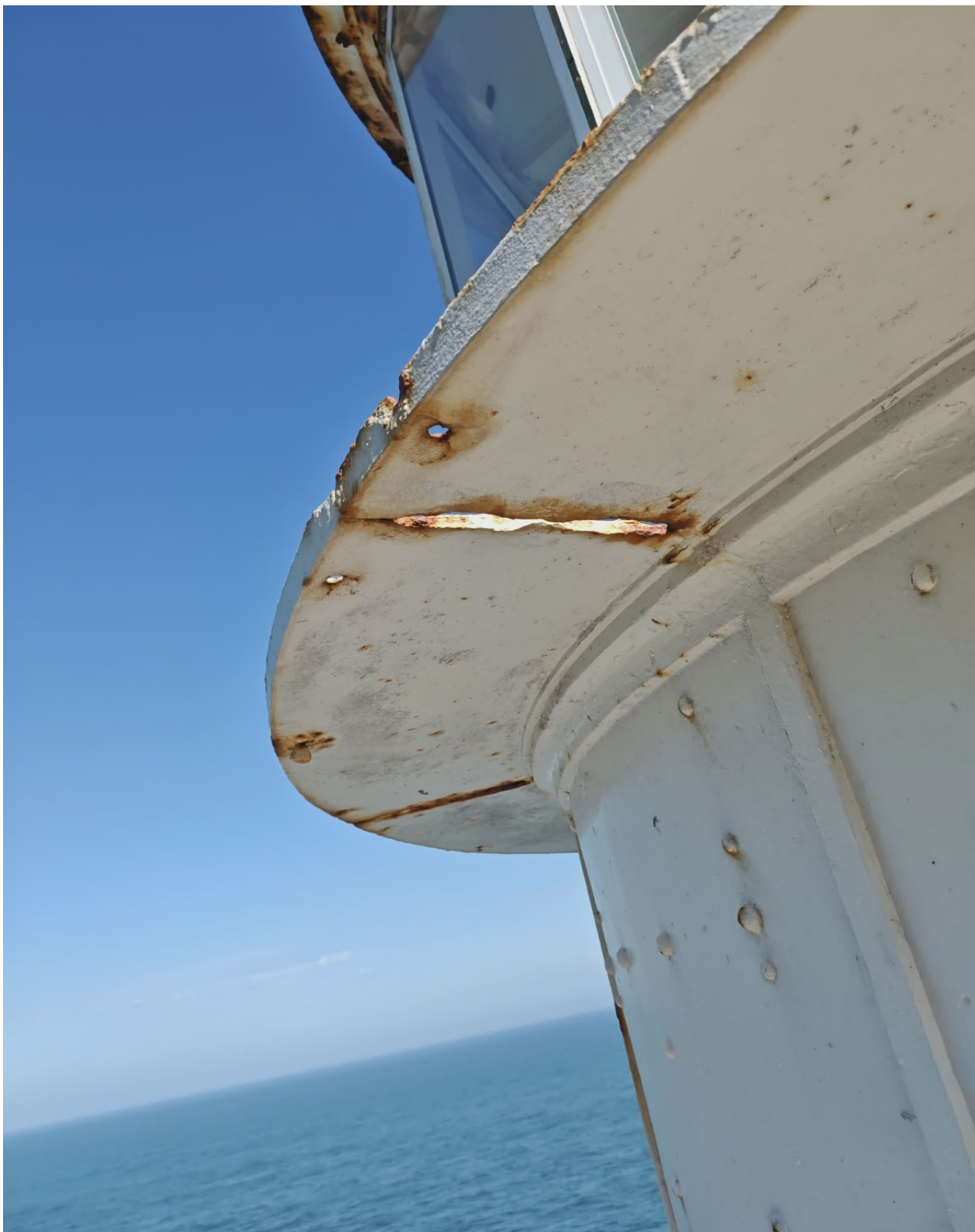
Figura 8: IMAGEM PARCIAL PISO DE APOIO EXTERNO - SERVIÇO DE REMOÇÃO DA TINTA ANTIGA, FERRUGEM E CONTAMINANTES, TRATAMENTO ANTICORROSIVO E APLICAÇÃO DE TINTA
