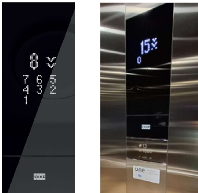
Foto 06: Display em LCD para identificação dos andares e direção de deslocamento
