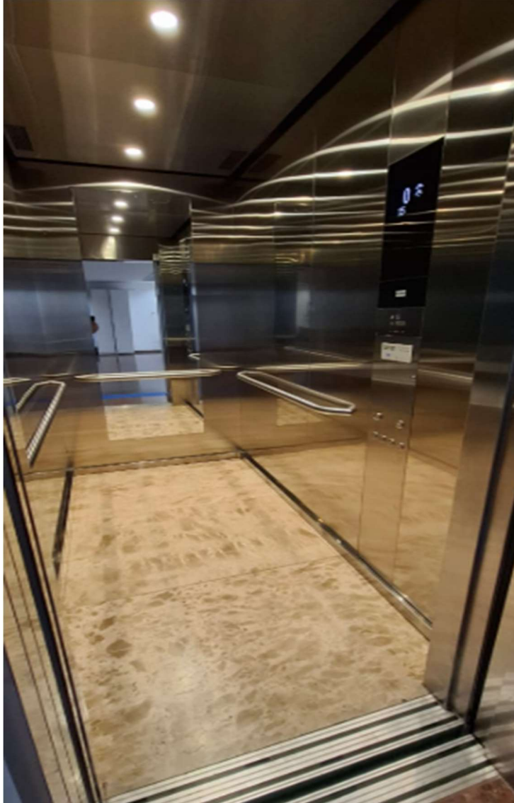
Foto 01: Modelo da cabina Nminispace em aço inox;
