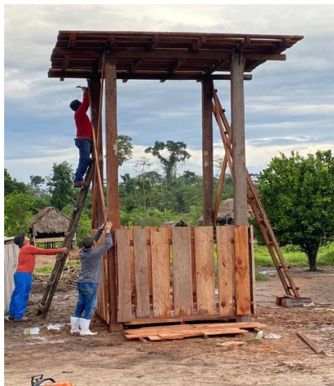
Figura 01 – Construção de Torre em madeira na aldeia Buaçú.
