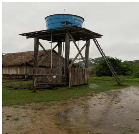
Figura 03 – Torres em madeira com caixa d'água instalada na aldeia Buaçú.
