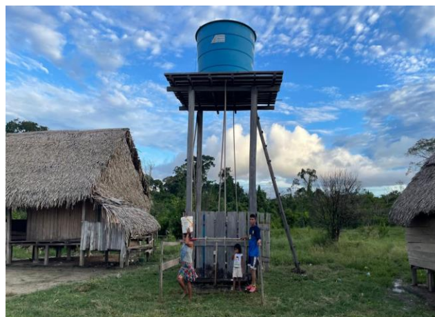
Figura 04 – Torre em madeira com caixa d'água instalada na aldeia Buaçú.
