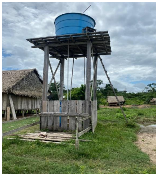
Figura 02 – Torre em madeira com caixa d'água instaladas na aldeia Buaçú.
