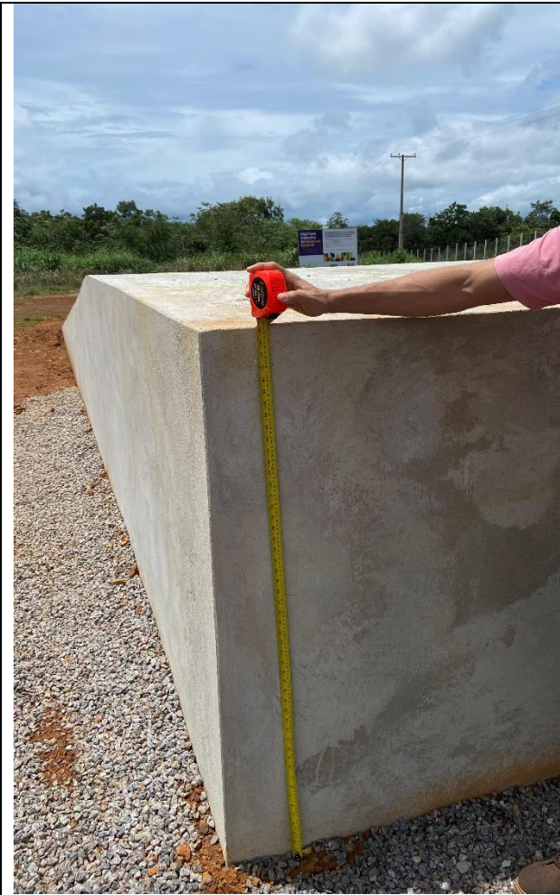
Foto 07: Altura da Rampa
