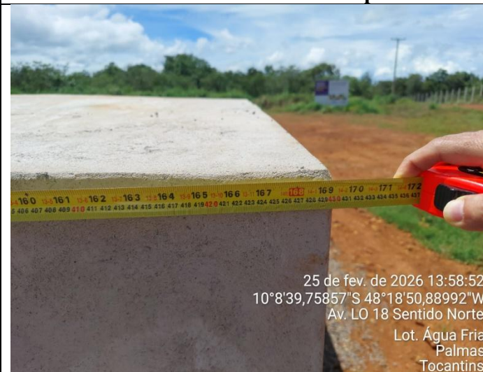
Foto 09: Largura da Rampa
