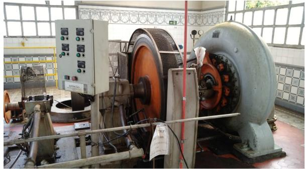
ae) Foto de um sistema de usina geradora de PCH, tipo FRANCIS e seu GERADOR montado. **Foto ilustrativa, sistema similar, não igual.** Imagem apenas para visualização de um sistema completo, em funcionamento e suas complexidades e grandezas.
