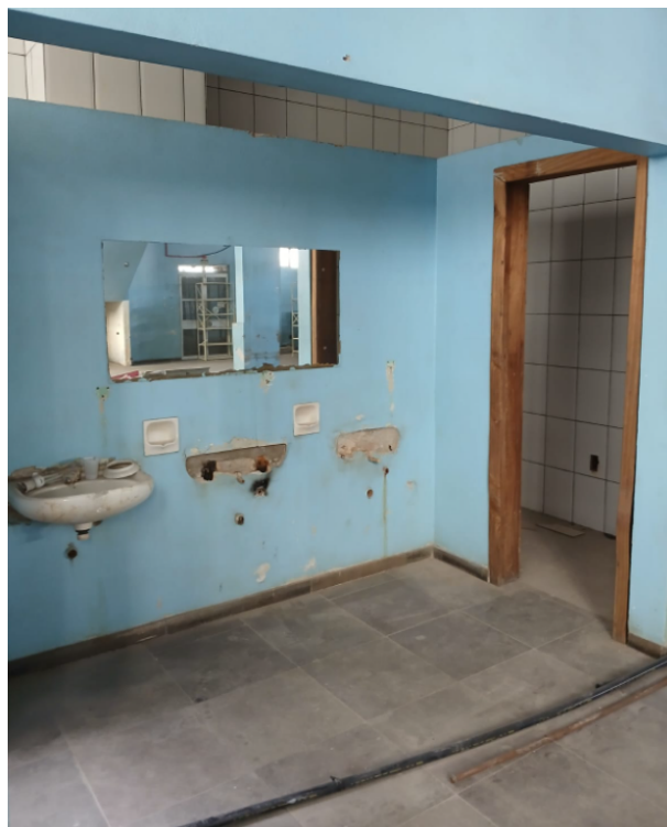
Figura 1 e Figura 2 - Situação atual do espaço a ser reformado
