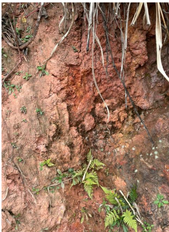
Figura 32 - Solo residual com sinais de umidade, na base do talude.
