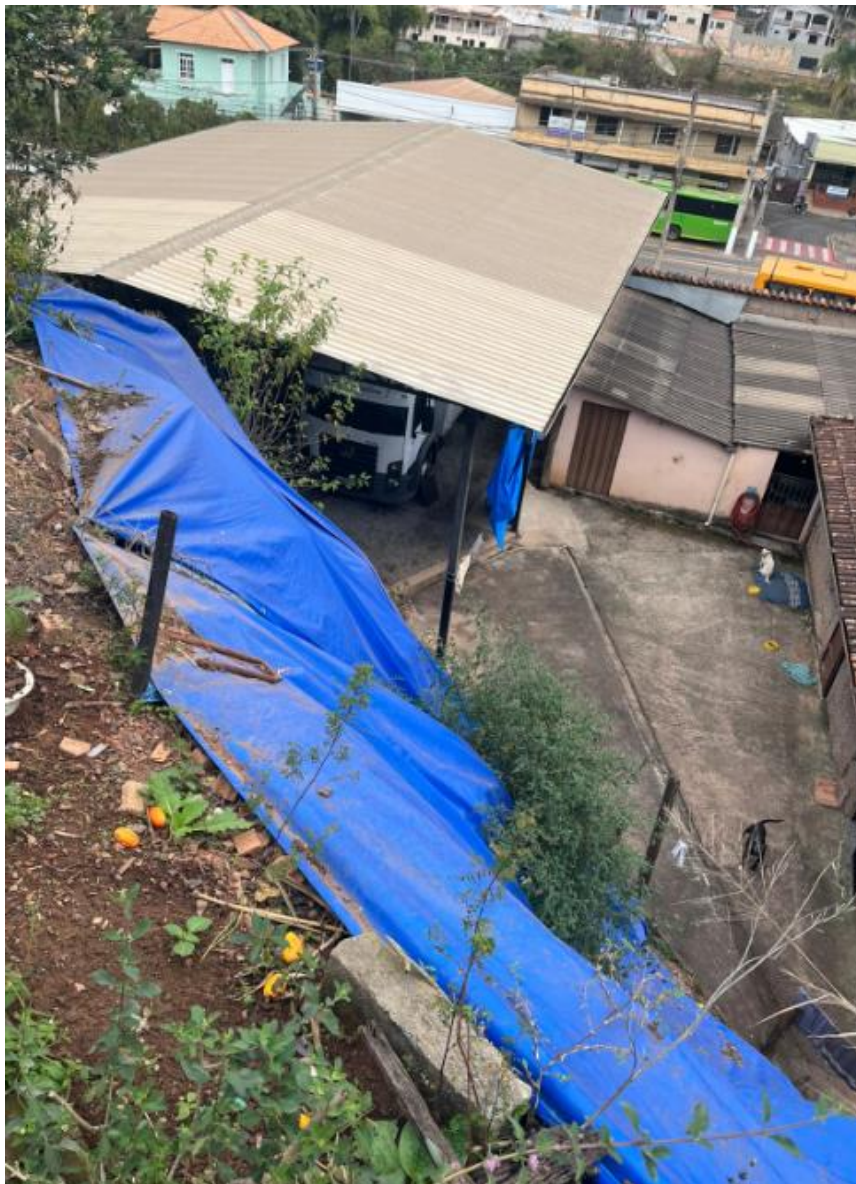
Figura 17 – Fotografia da área de estudo com presença de lona impermeabilizante recobrendo a face do talude.
