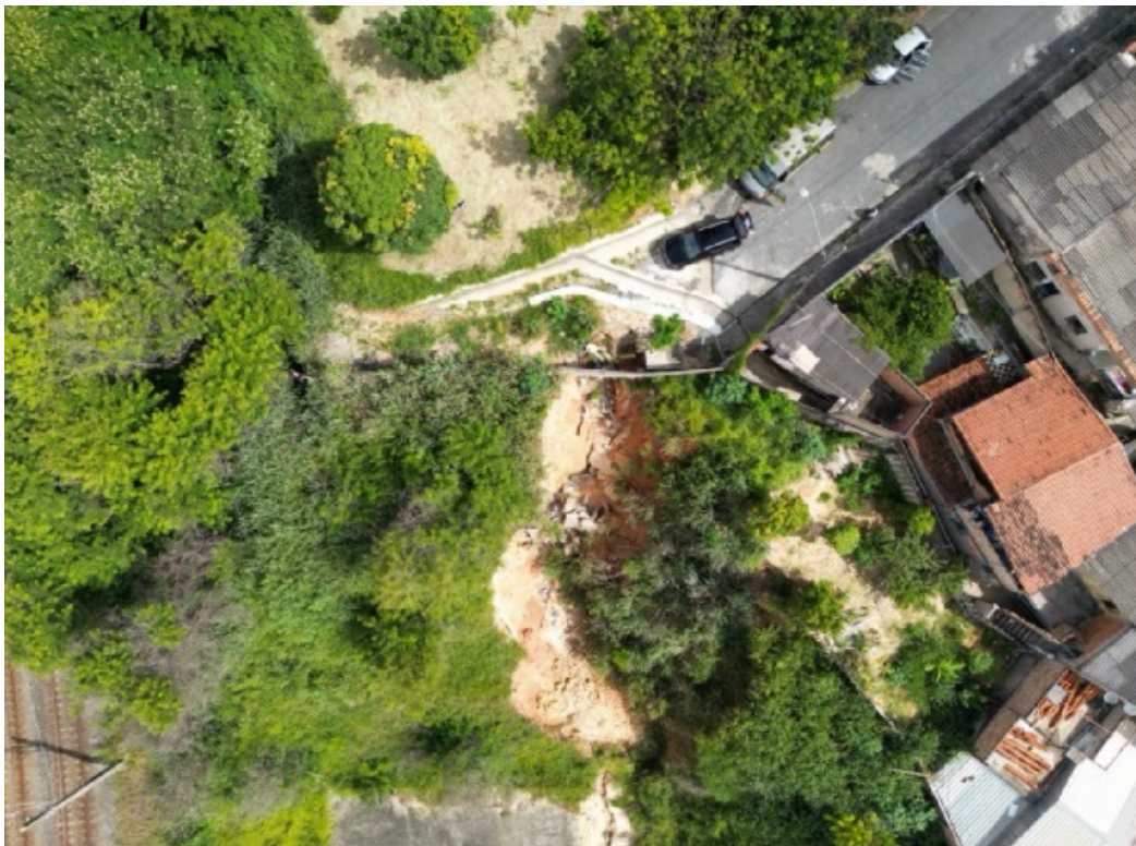
Imagem 5: vista de cima da erosão e final da rua Marcelino Ferreira. Fev/2025
