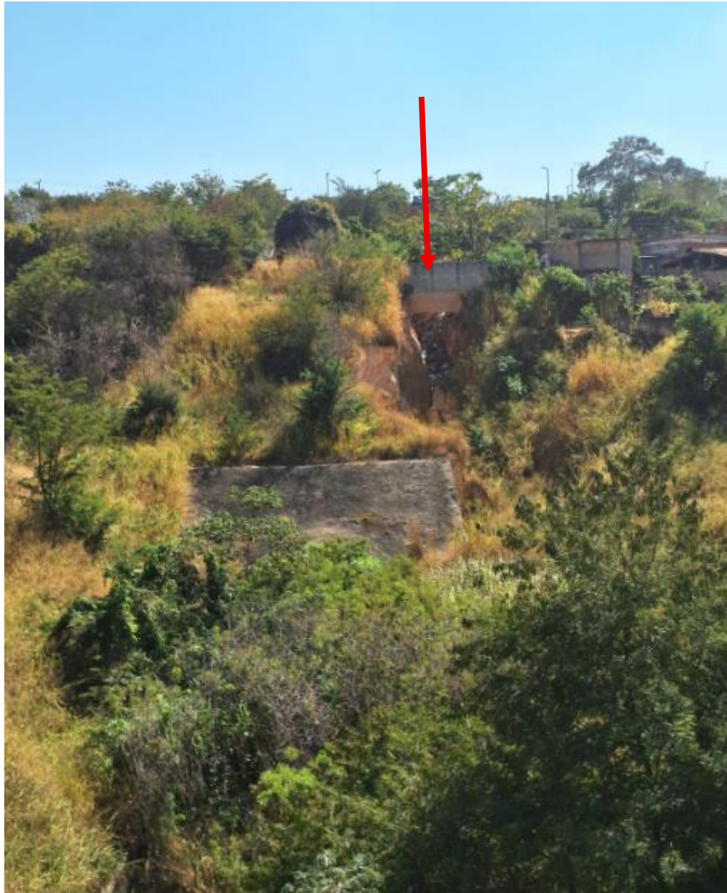
Figura 15 - Fotografia tirada a sul da região do talude. Observa-se processo de voçorocamento ativo, com movimento de rejeitos antrópicos pela encosta.
