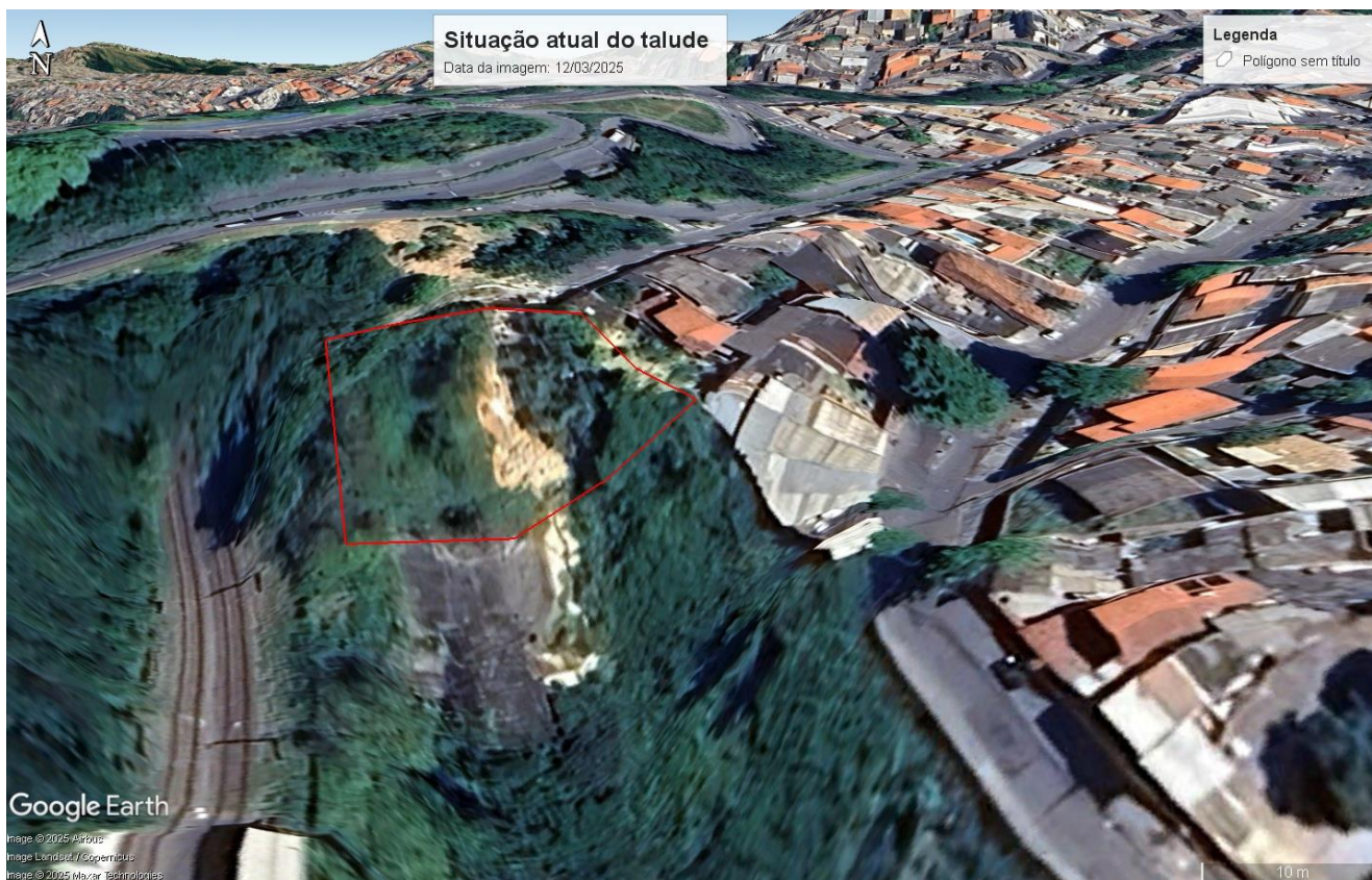
Figura 24 - Situação atual do talude (Imagem de março de 2025).
