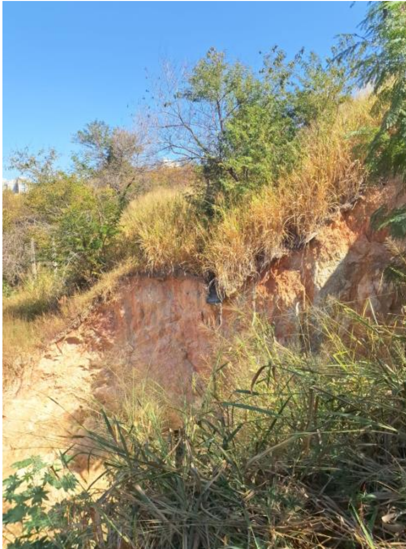
Figura 18 - Fotografia da parede oeste da ravina, responsável pela exposição do solo local.
