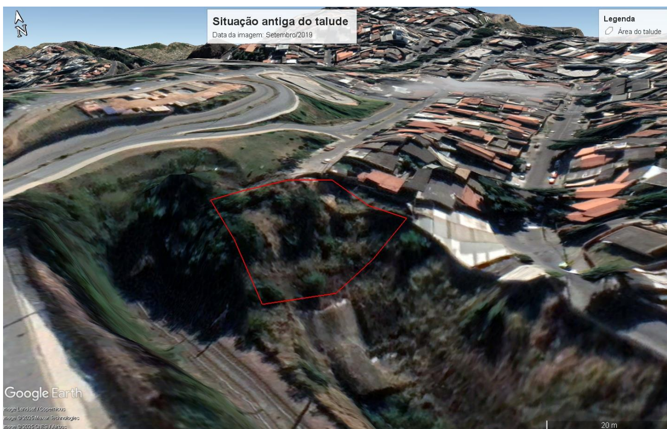
Figura 21 - Situação do talude em estudo no mês de setembro de 2019
