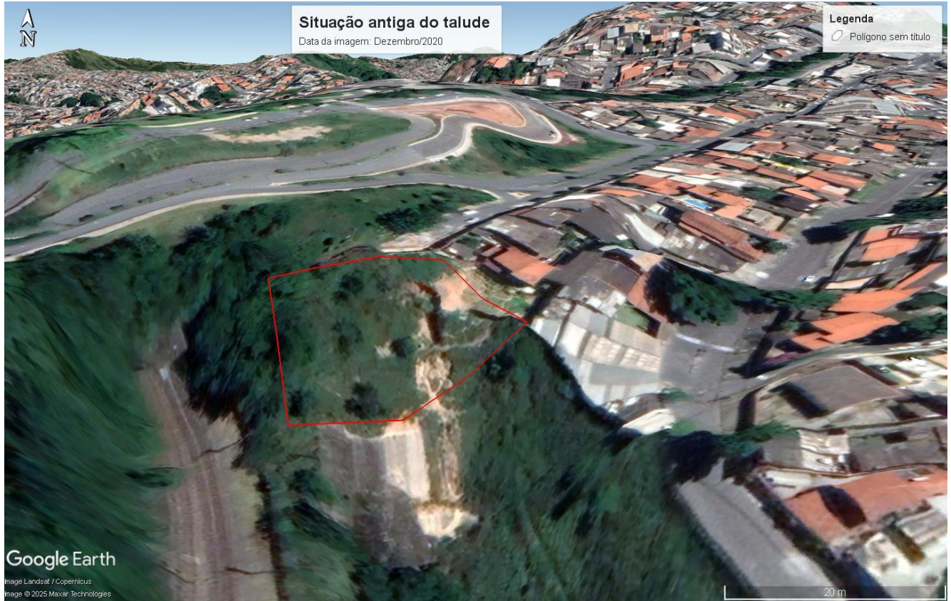
Figura 23 - Imagem do talude no mês de dezembro de 2020.
