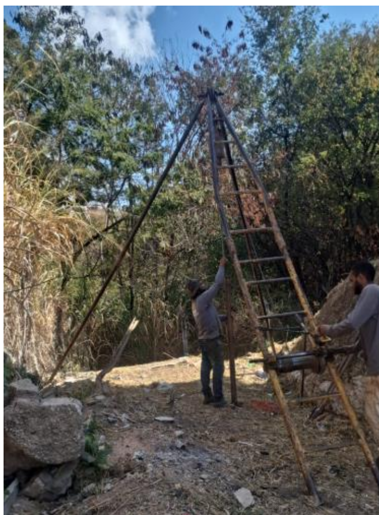
Figura 27 - Sondagem SPT realizada durante visita técnica.
