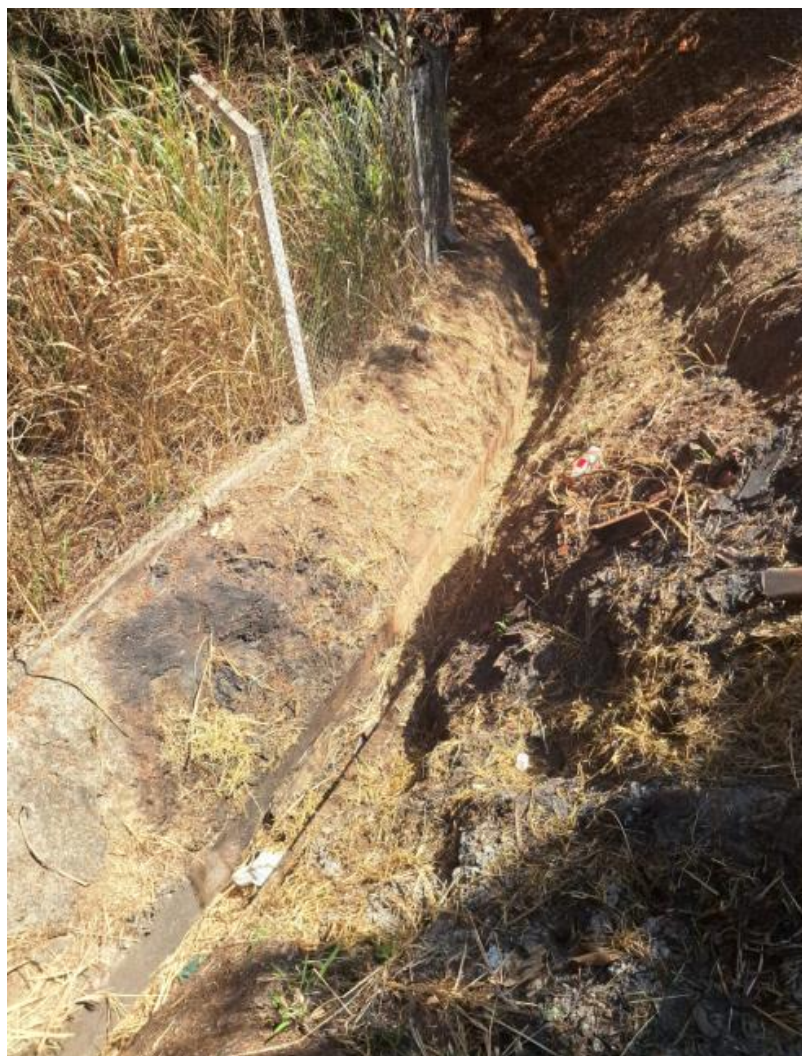
Figura 30 - Canaleta localizada próximo a crista do talude.
