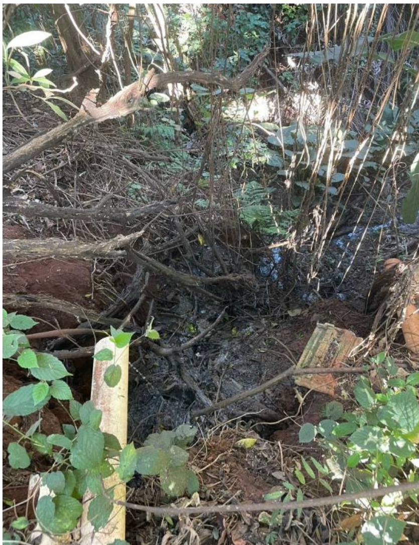
Figura 16 - Solo local extremamente saturado e com entulhos.
