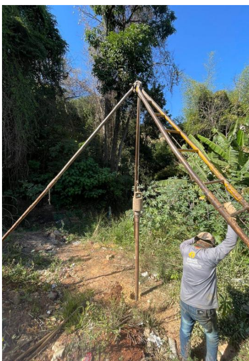
Figura 21 - Sondagem SPT realizada
