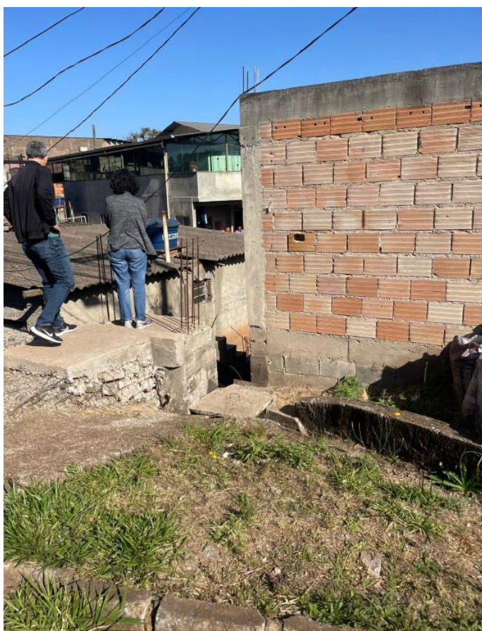
Figura 22 - Rua à montante da área de estudo, com drenagem em direção ao vale da região vegetada.
