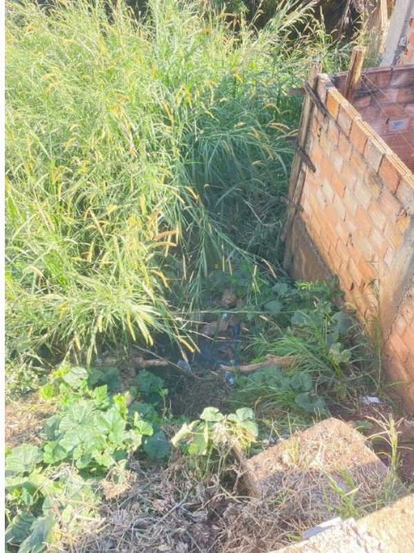
Figura 14 - Presença de entulho em encosta de baixa declividade.
