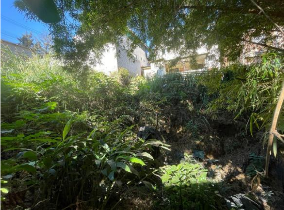
Figura 17 - Fundo do vale local. Sem presença de estruturas de drenagem.
