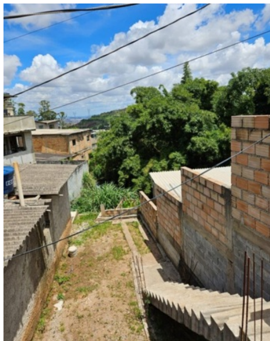
Figura 11 - Residências situadas abaixo do nível da rua Adriano Chaves Matos (obs.: essas residências estão fora da área de propriedade da União)
