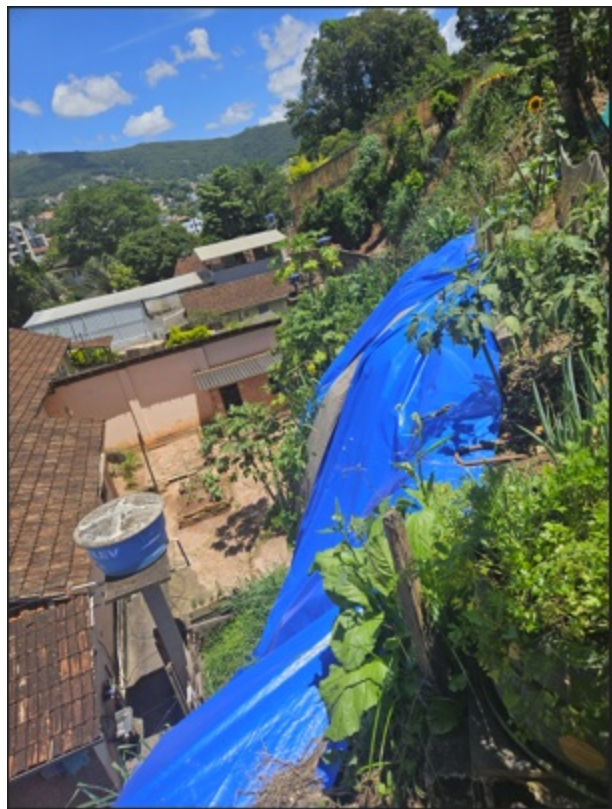
Figura 3: vista lateral direita da encosta e residências abaixo do talude. Lonas doadas pela SPU-MG instaladas.
