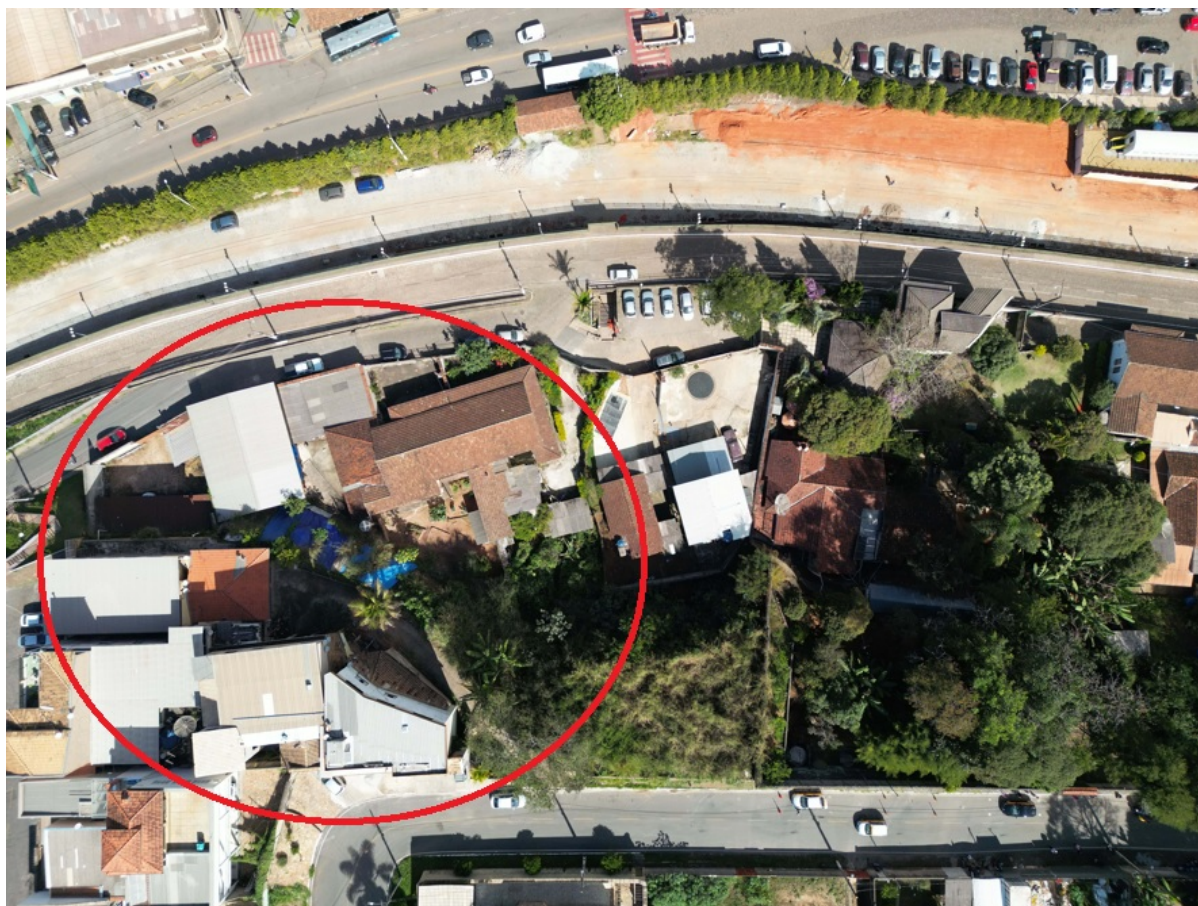
Figura 1: imagem aérea da área afetada. Encosta e residências entre a Av. Manoel Salvador de Oliveira e Rua Dr. Hélio Ferreira Bastos.
