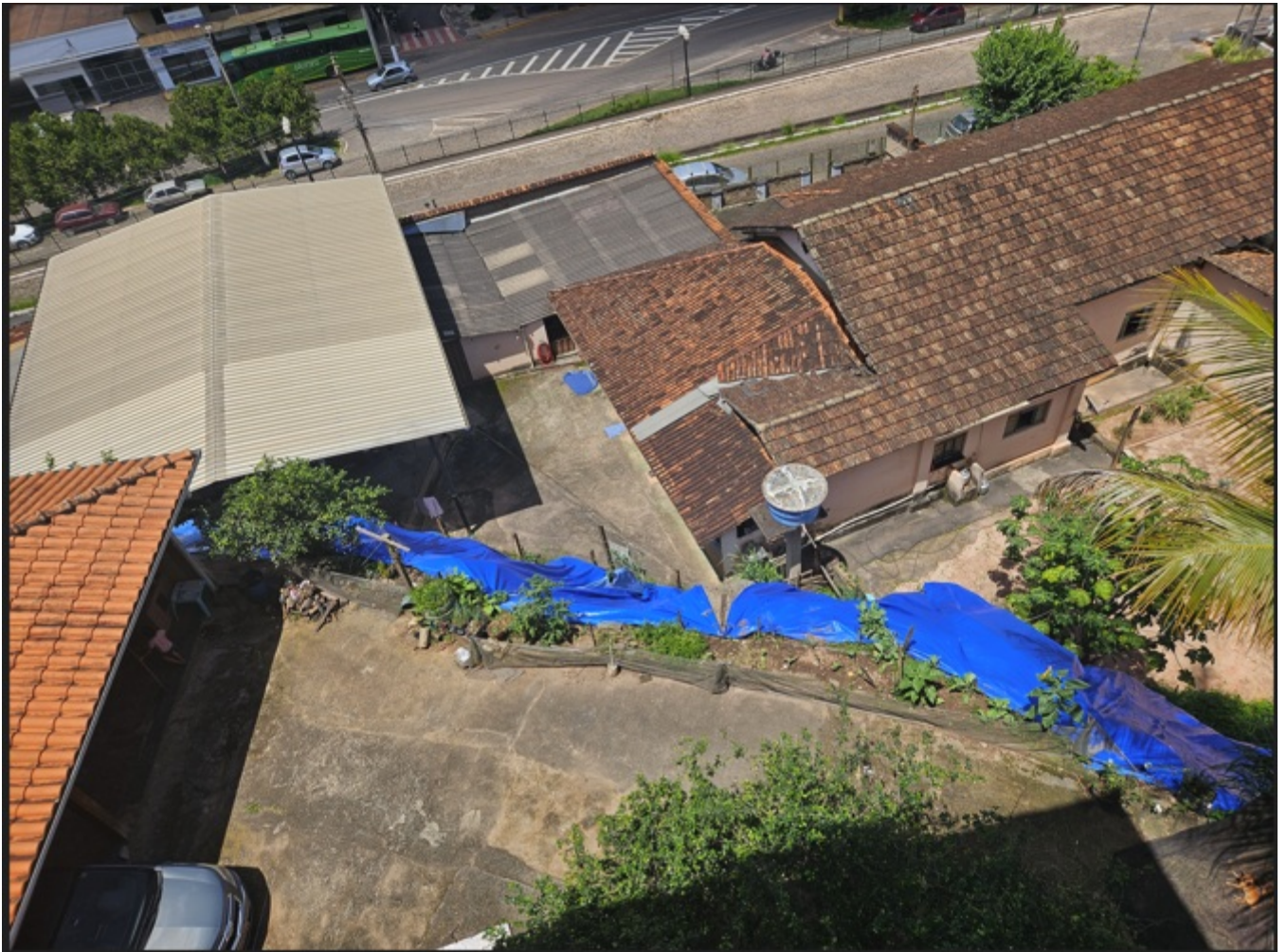
Figura 2: vista geral da encosta e residências. vista de cima, do terraço da casa do Sr. Daniel Vianna.
