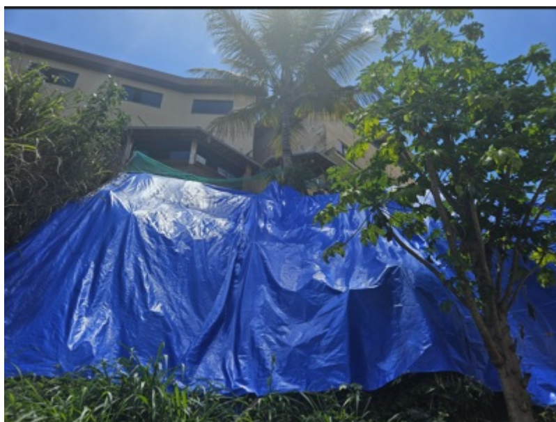
Figura 5: vista debaixo do talude, da casa do Sr. Murilio, da extinta RFFSA. O mato alto ajudando a minimizar processos erosivos.
