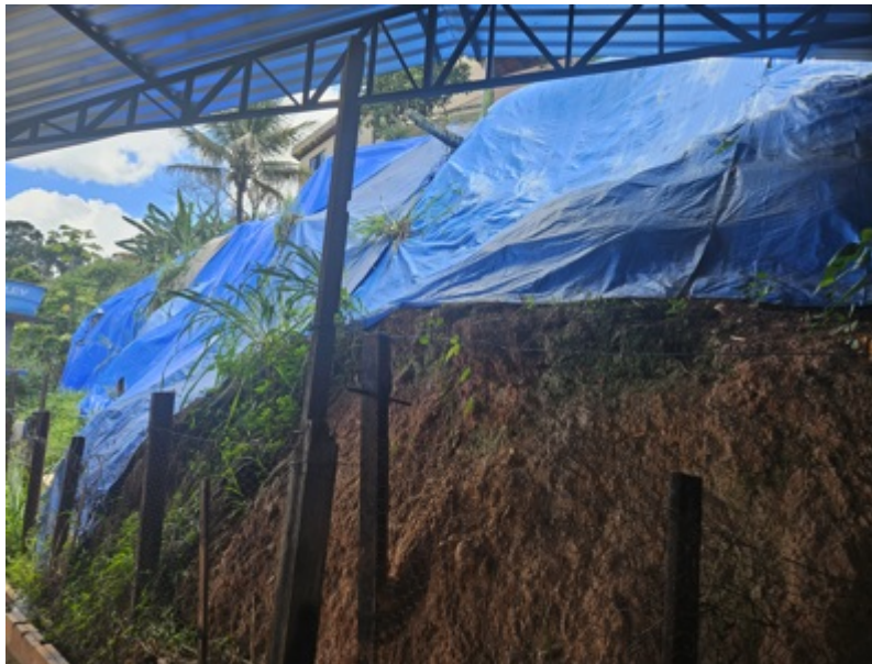
Figura 7: vista debaixo do talude, da residência Rua Dr. Hélio Ferreira Bastos, nº 265, da extinta RFFSA. Estacas de ferro instaladas pelo morador.
