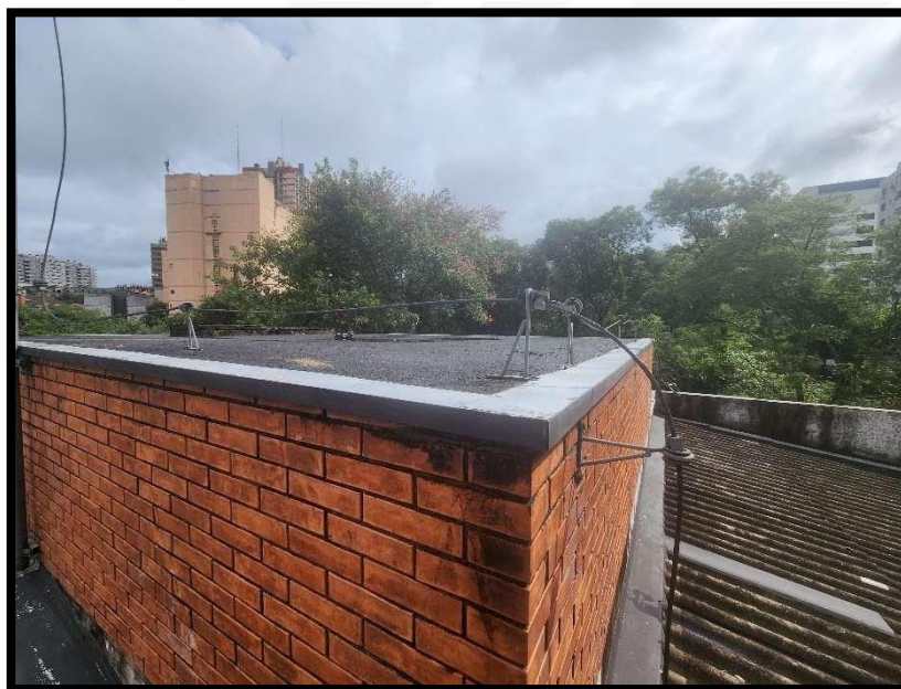
Figura 7 - Reservatório de concreto
