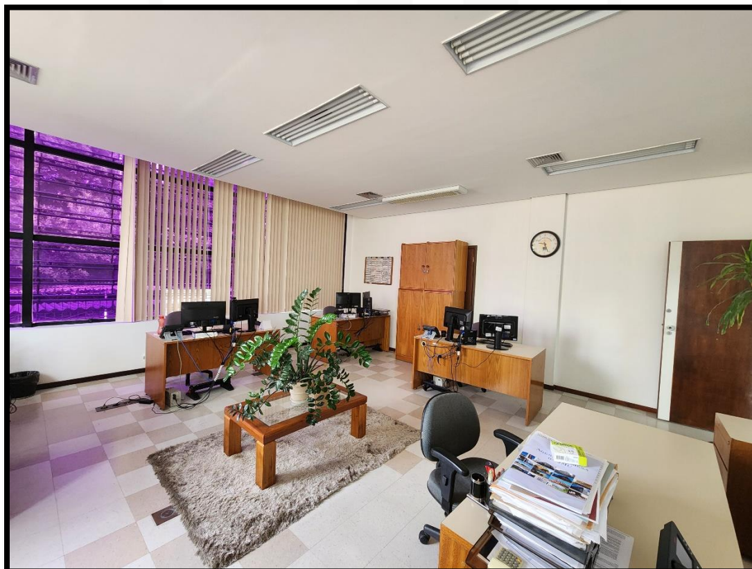
Figura 2. PONTOS DE CABEAMENTO DE PISO QUE DEVEM SER INUTILIZADAS CONFORME SOLICITADO.
