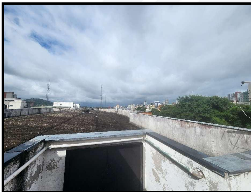
Figura 3 - Rufos de proteção das Alvenarias
