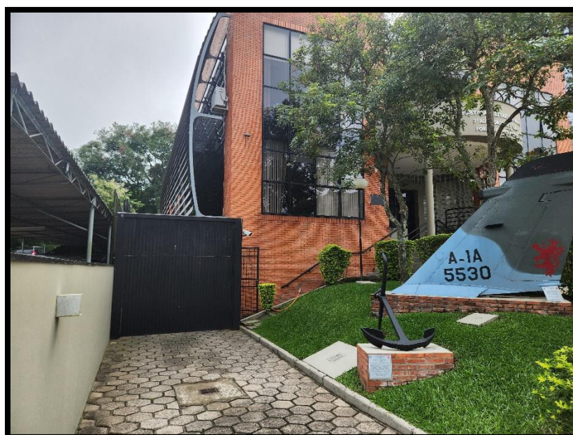
Figura 1 - Situação atual da saída de água pluviais
