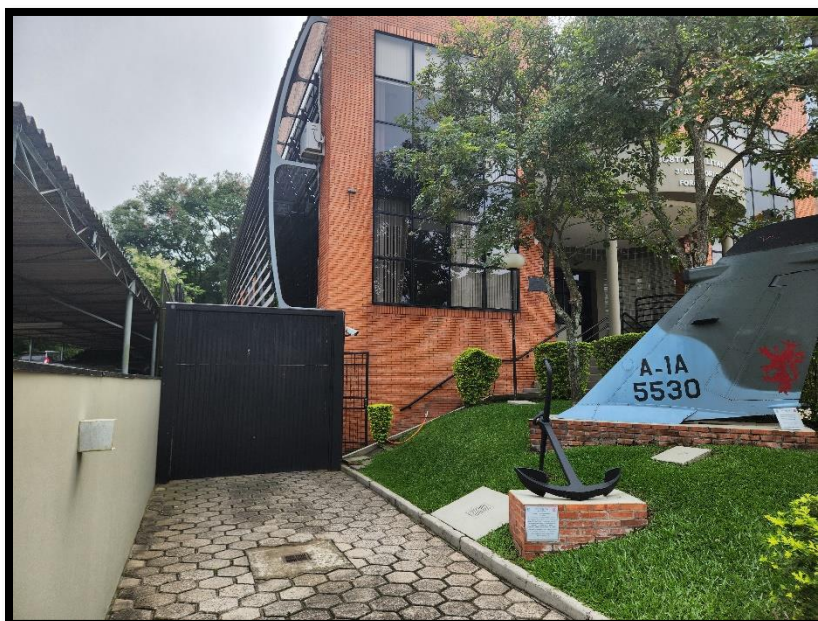
Figura 1 - Situação atual da saída de água pluviais
