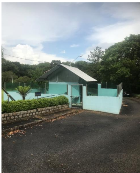
Casa de Proteção
