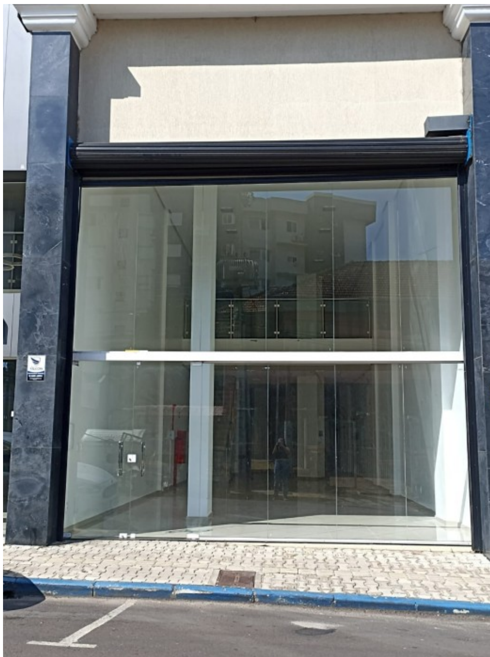
Foto 02: Local de instalação da placa.
