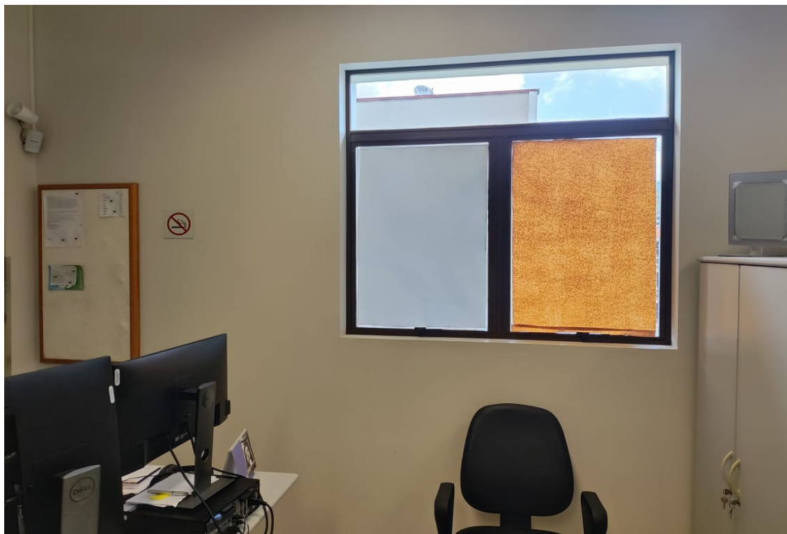
Foto 01: Janela onde as persianas deverão ser instaladas.
