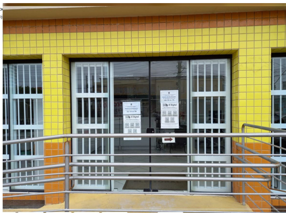
Foto 02: Local de instalação da placa.
