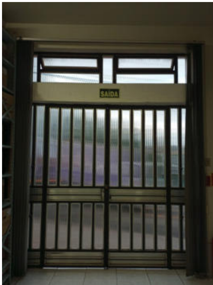
Foto 13: Persiana para manutenção, conforme descrito no item 3.2.
