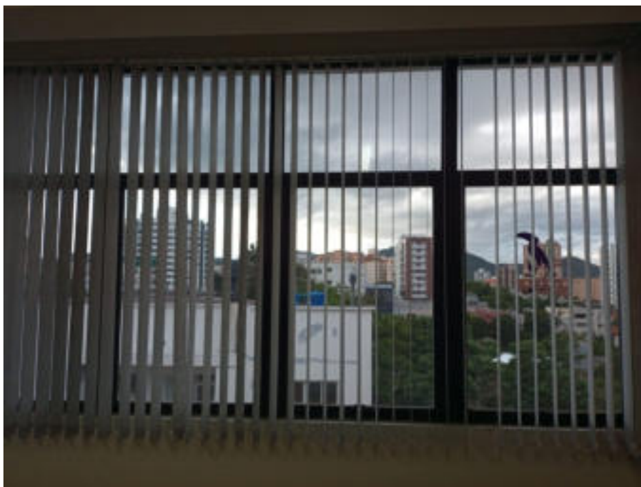
Foto 08: Persiana para manutenção, conforme descrito no item 3.2.
