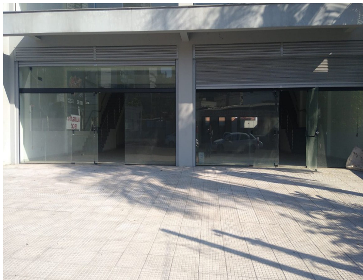
Foto 02: Local de instalação da placa.
