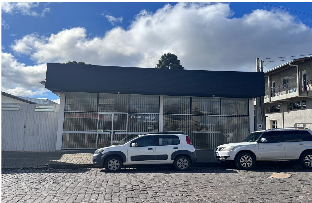
Foto 02: Local de instalação da placa.
