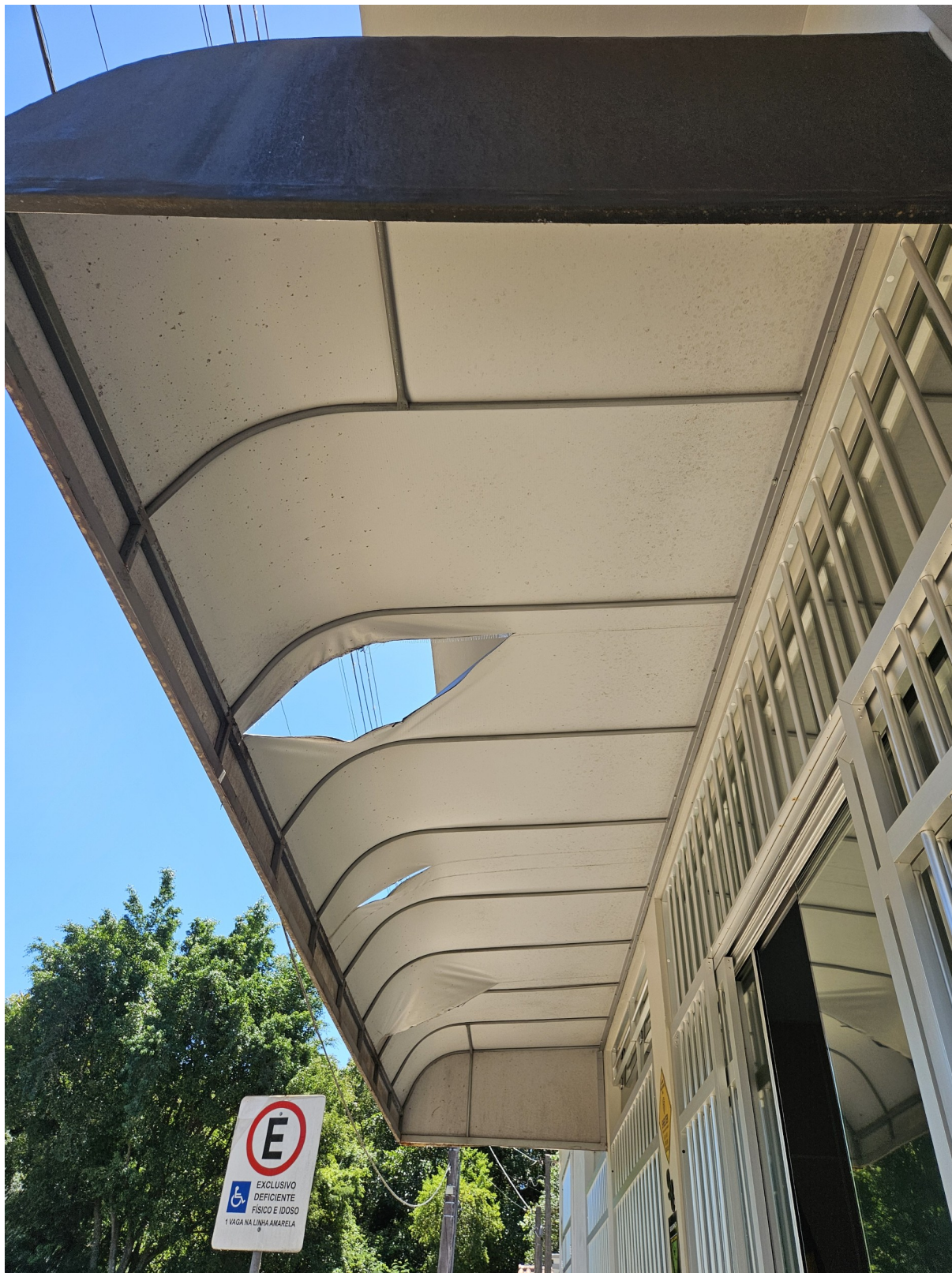
Foto 01: Estado atual do toldo em seu local de instalação.
