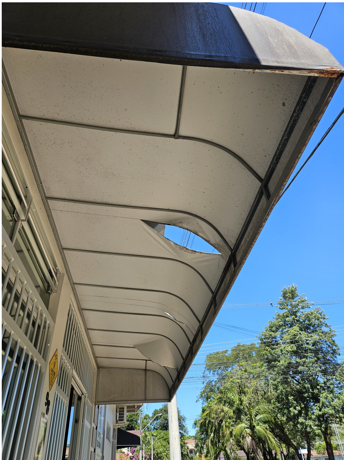
Foto 02: Estado atual do toldo em seu local de instalação.
