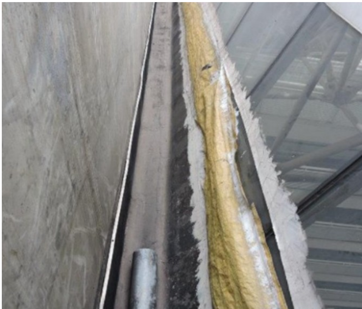
Imagem 1 - Detalhe da situação da vedação da junta entre a estrutura metálica e a calha de concreto, com lona improvisada para estancar falhas na vedação original
