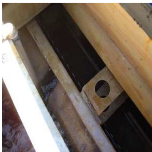
Figura 08 – suporte do tubo clorador (placa de fibra furada) onde são alojadas as pastilhas de hipoclorito de cálcio.
