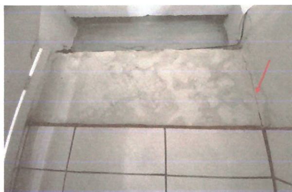
Foto 17 - Banheiro: trincas e infiltrações
