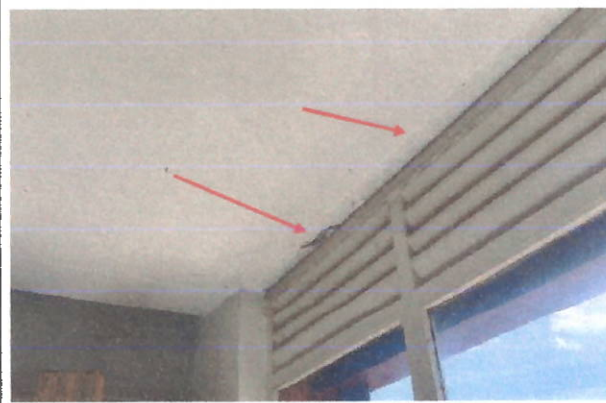
Foto 20 - Sala adm: infiltrações e descolamento da pintura
